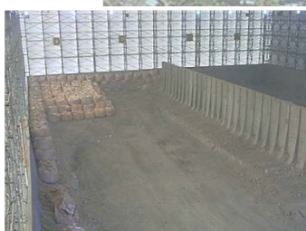
瓦礫保管 テント内
