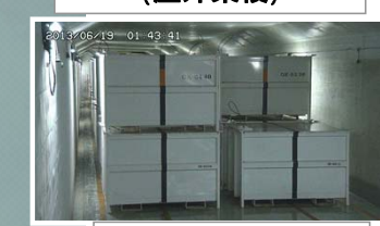
固体廃棄物貯蔵庫
