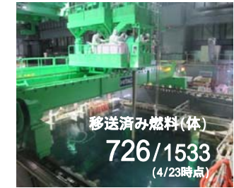
(燃料取り出し状況)
