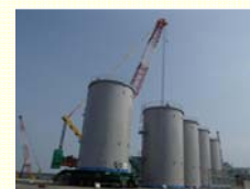
< 陸揚げされたタンク >
