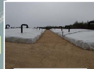
伐採木一時保管槽
