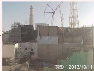
大型ガレキ撤去後
