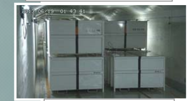
固体廃棄物貯蔵庫
