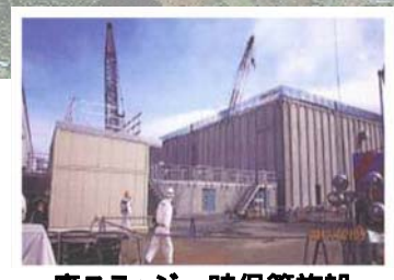
廃スラッジ一時保管施設
