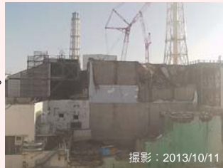
大型ガレキ撤去後
