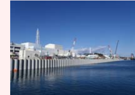
海側遮水壁工事状況
