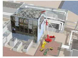
原子炉建屋上部のガレキ撤去
