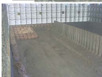
瓦礫保管テント内
