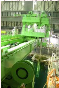
燃料取り出し状況
