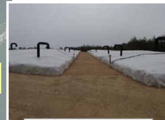
伐採木一時保管槽
