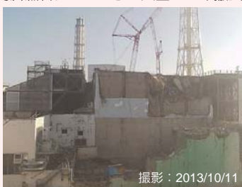
大型ガレキ撤去後
