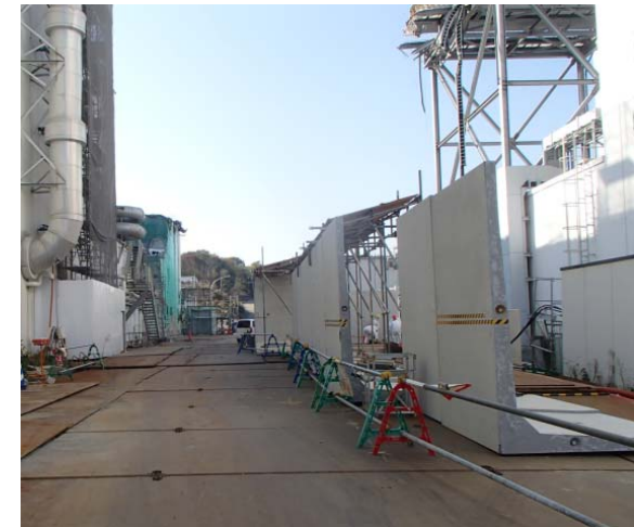
② 2号開削ダクト現況
