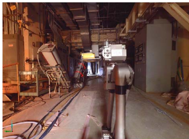
図4 調査エリア状況
