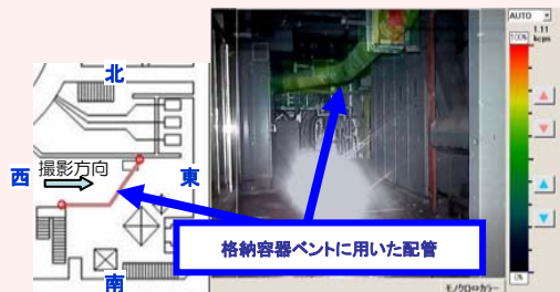
格納容器ベントに用いた配管周辺のガンマカメラ撮影データ
