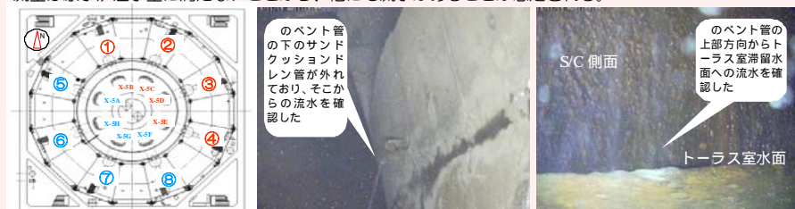
サンドクッションドレン管及びベント管上部からの漏水状況
