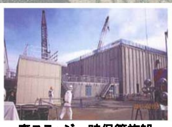
廃スラッジ一時保管施設
