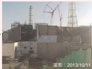
大型ガレキ撤去後
