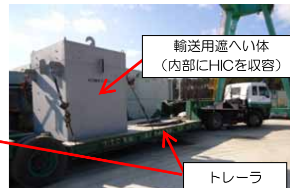
一時保管施設トレーラ寄付きの様子
