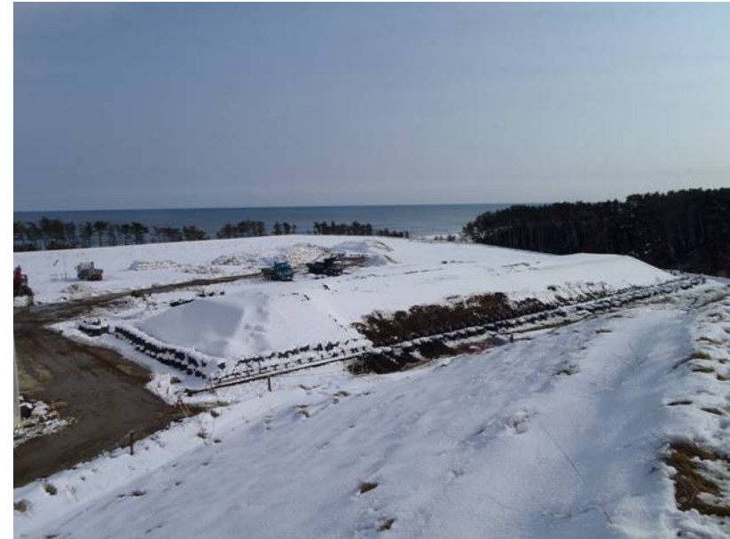
1 槽目の状況（1/16撮影）
