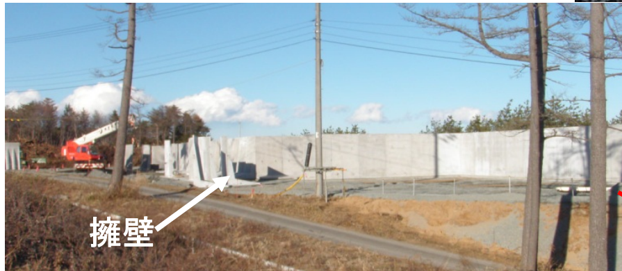
一時保管エリアGの状況（1/25撮影）
