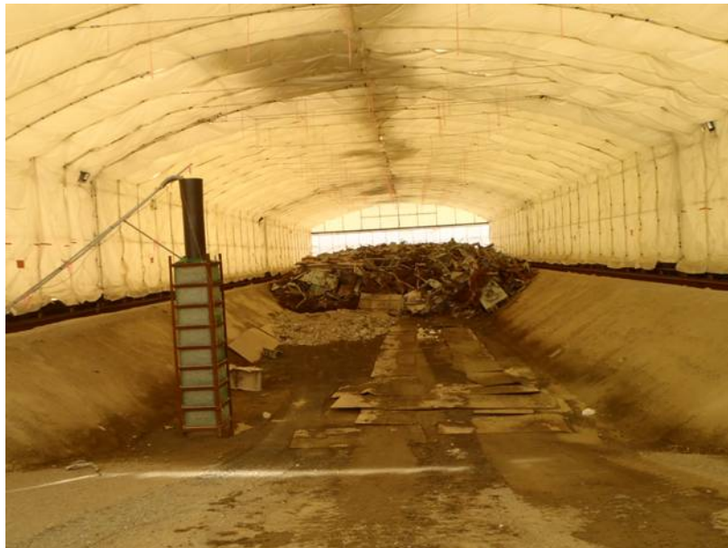
2 槽目の状況（1/16撮影）
