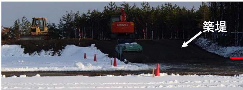
一時保管エリアGの状況（1/16撮影）
