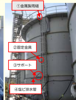
<雨樋設置状況>
