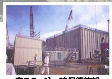
灰スラッジ一時保管施設
