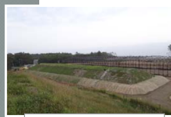
覆土式一時保管施設
