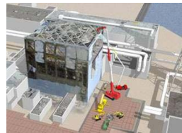
原子炉建屋上部のガレキ撤去
