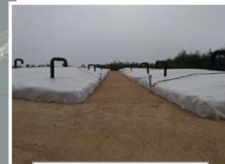
伐採木一時保管槽
