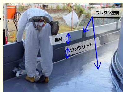
<鋼材による高上げ状況>
