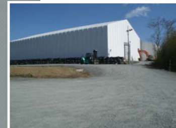
瓦礫保管テント
