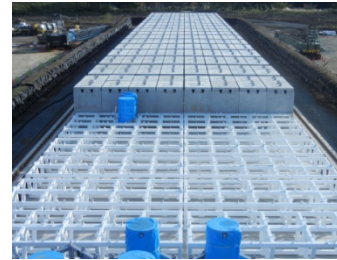
セシウム吸着塔一時保管施設
