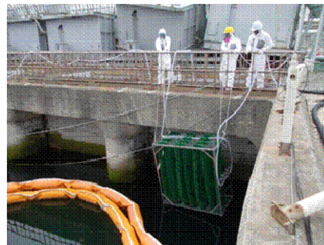
設置作業の様子
