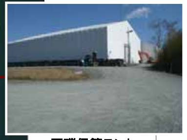
瓦礫保管テント
