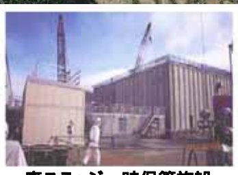
廃スラッジ一時保管施設
