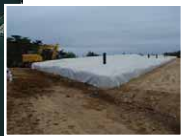
伐採木一時保管槽
