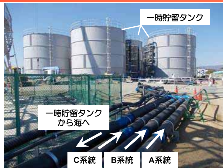
移送配管設置状況（各系統～一時貯留タンク～海）
