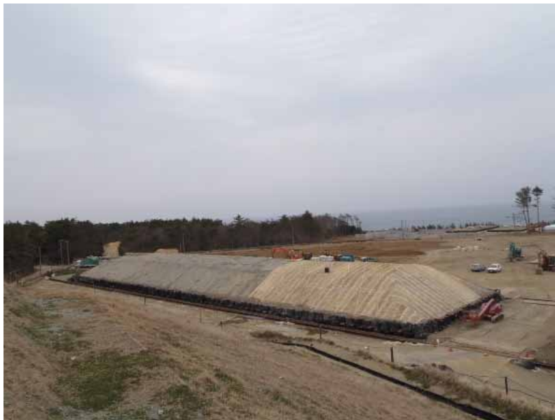
2槽目の状況 (3/25撮影)
