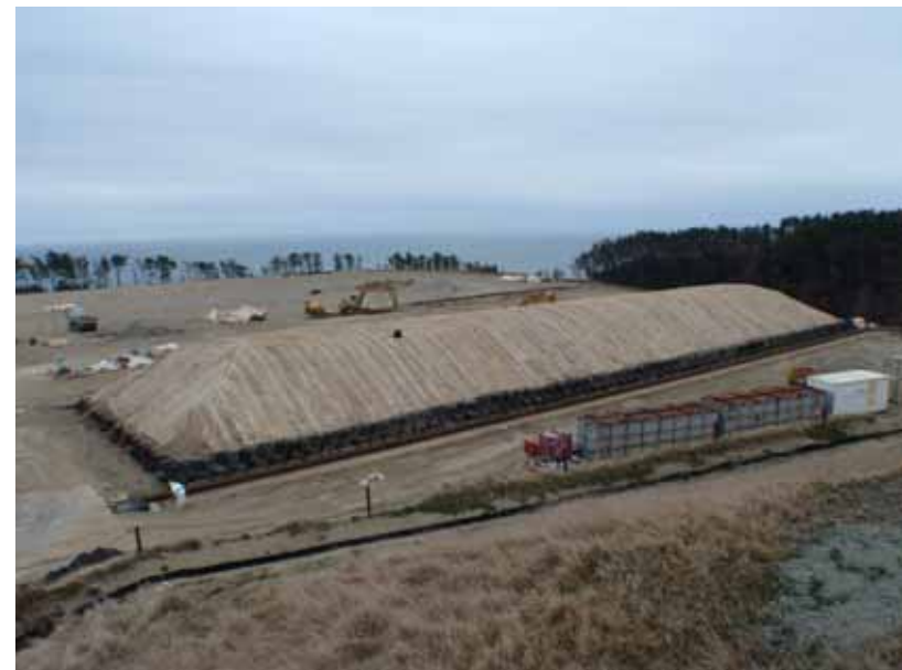
1槽目の状況 (3/27撮影)
