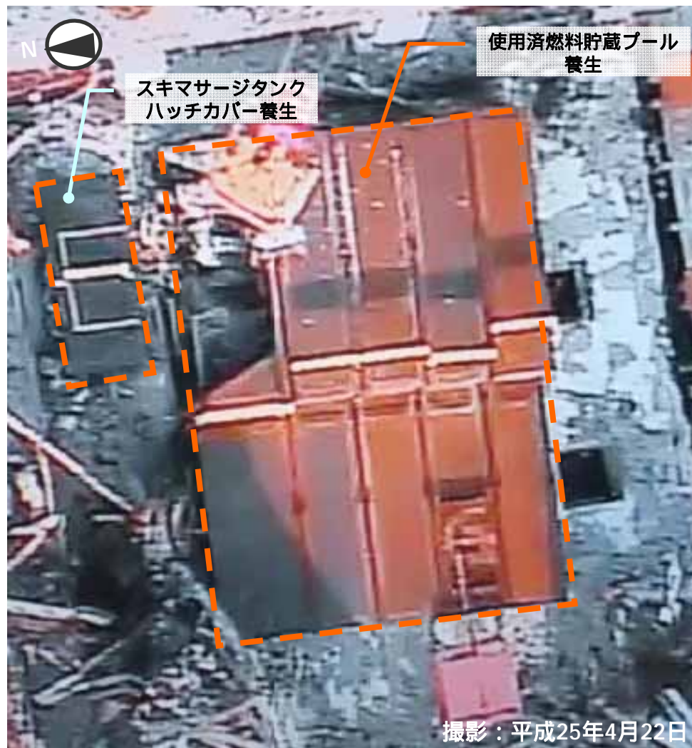
撮影：平成25年4月22日 使用済燃料貯蔵プール養生（第一段階）および スキマサージタンクハッチカバー養生の設置完了
