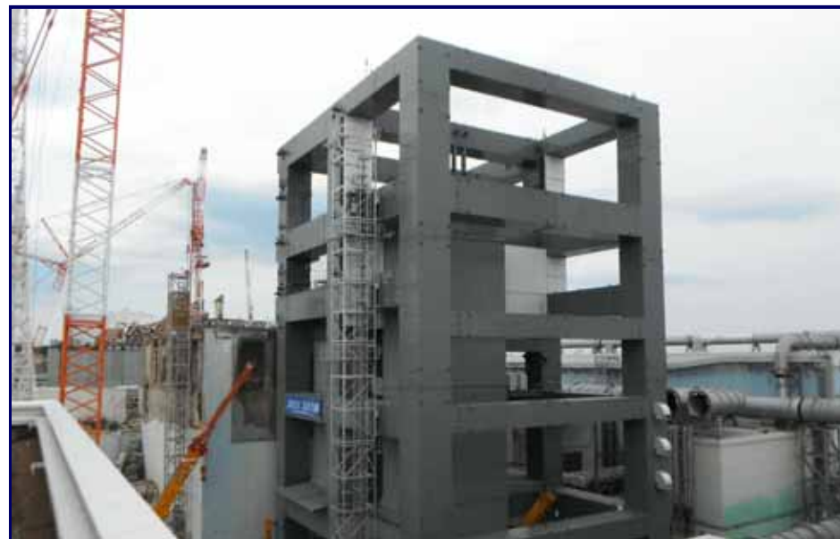
鉄骨建方進捗状況：平成25年4月10日（時点）
