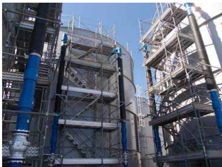
一時貯留タンク設置状況
