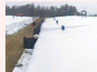
伐採木一時保管槽の設置状況(4/2)
