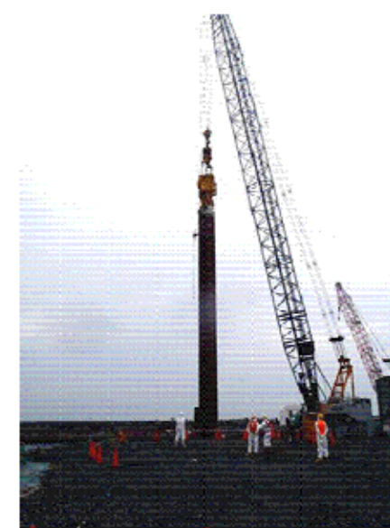
図2：遮水壁鋼管矢板打設
