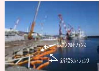
シルトフェンス交換の様子
