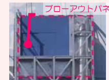
閉止パネル設置完了後
