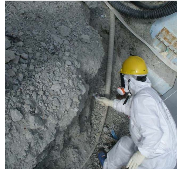
4号機周辺ガレキの採取状況
