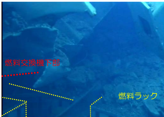
燃料交換機の下部と燃料ラックの状況
