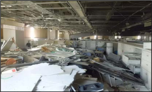
上階執務室 (工事前)
