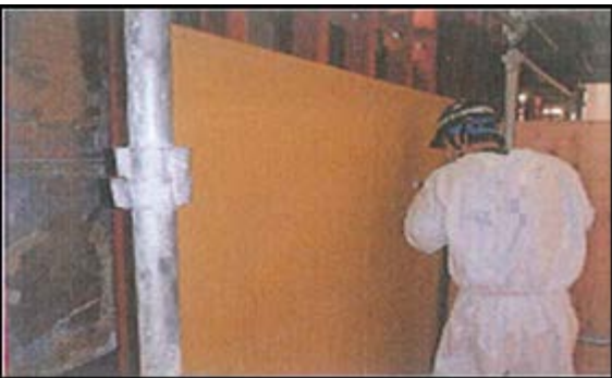
免震棟通信機械室壁遮へい
