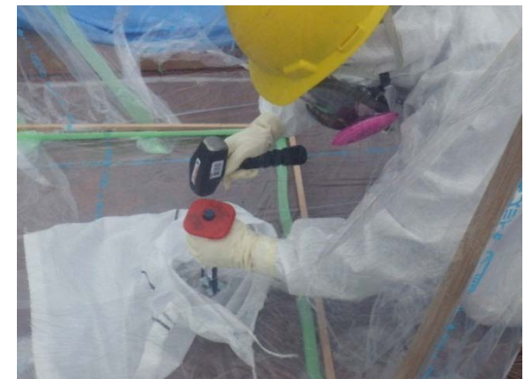
ガレキ(コンクリート)の粗粉碎
