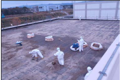
屋上コンクリート撤去
