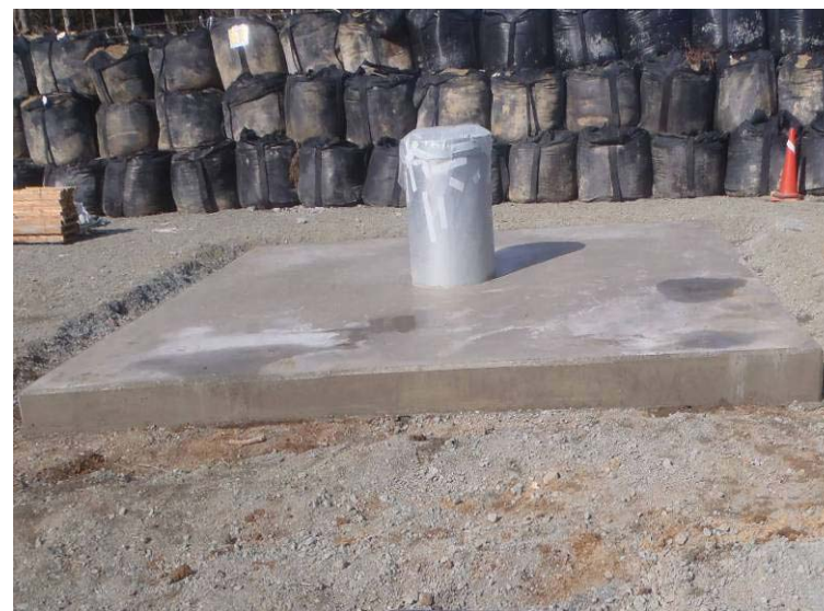
No.9揚水井（B系統）設置完了
