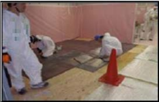
免震重要棟前休憩所床鉛遮へい
