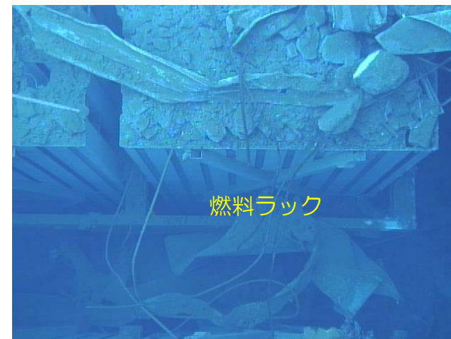
燃料ラックの状況
