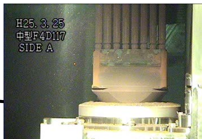
下部タイプレート、被覆管 変形・損傷無し
