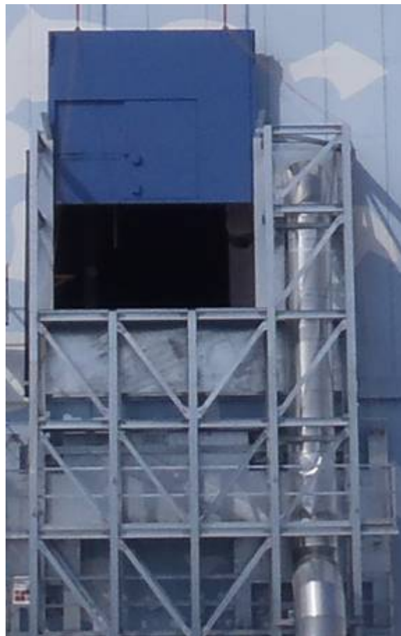
閉止パネル設置中
