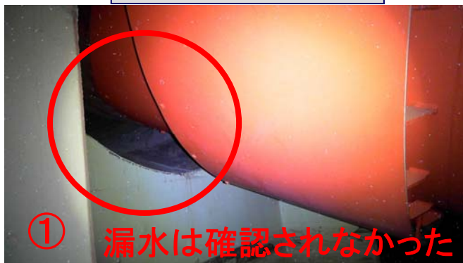
ベント管スリーブ端部
