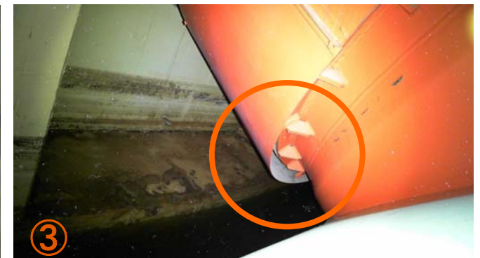
ベント管ベローズカバー下部
