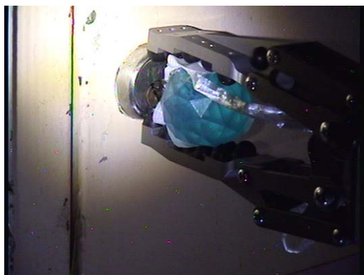
1. TIP室扉鍵開け作業
