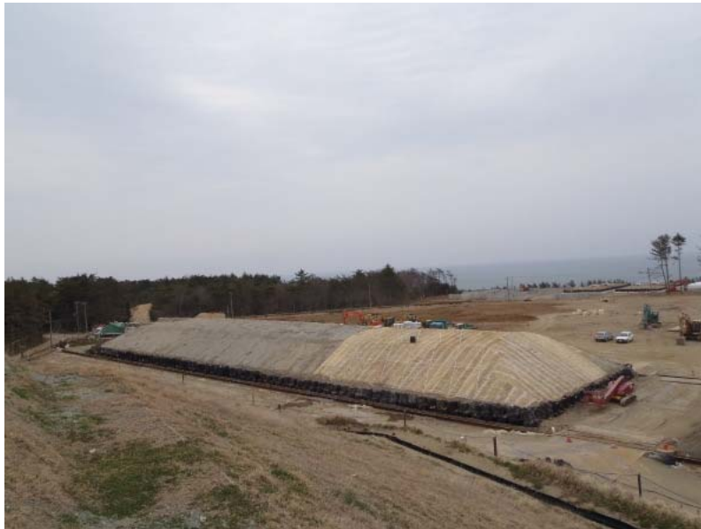
2槽目の状況 (3/25撮影)
