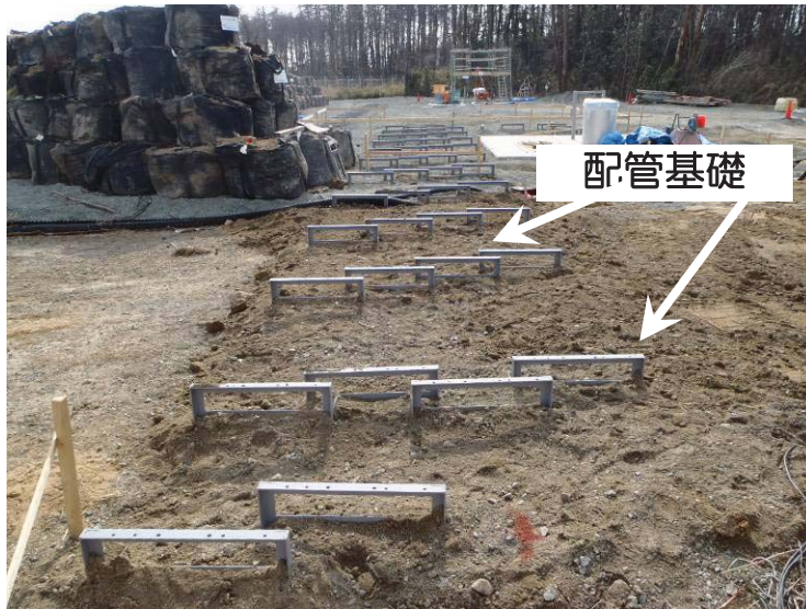
(B系統) 配管基礎設置状況
