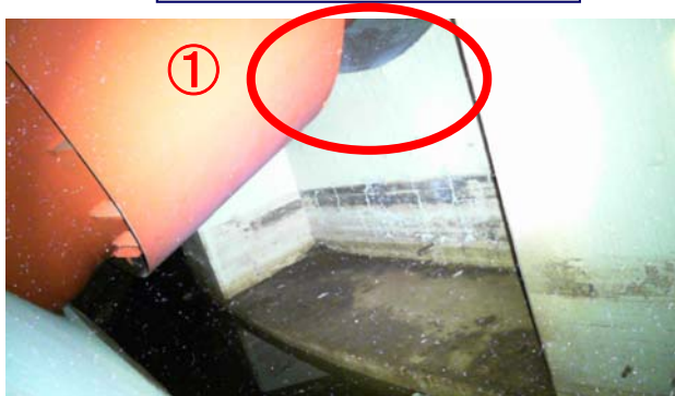
ベント管スリーブ端部
