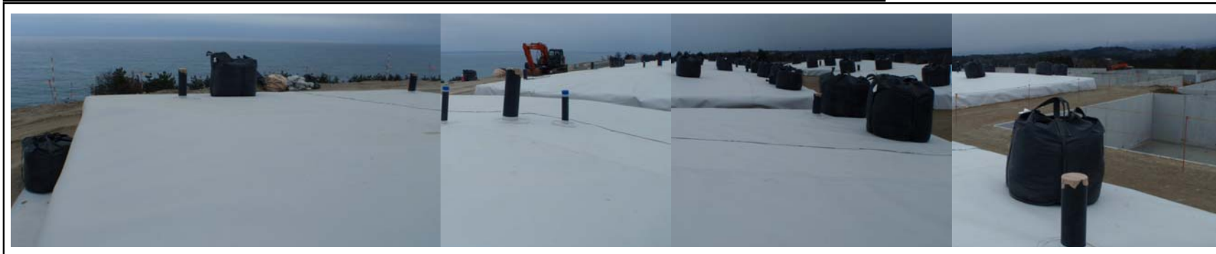
一時保管エリアTの状況（3/27撮影）
