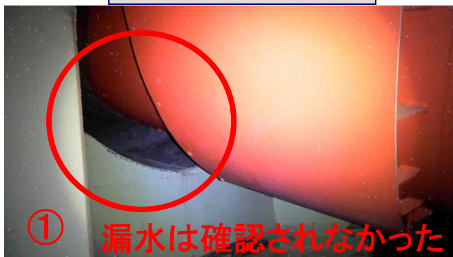
ベント管スリーブ端部
