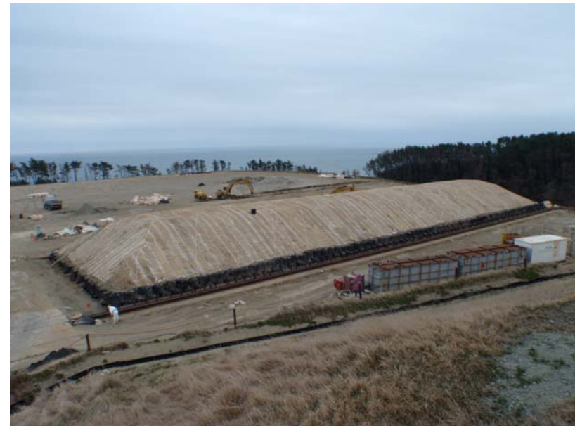
1槽目の状況 (3/27撮影)
