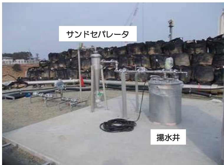
No.1揚水井および揚水設備（A系統）設置完了
