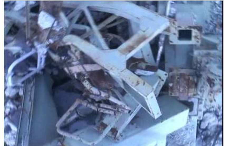
東側エンドトラック
