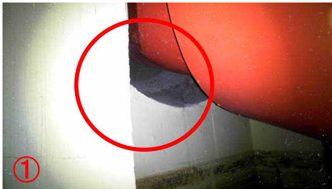
ベント管スリーブ端部
