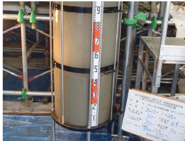
〔打設開始30 分後〕
