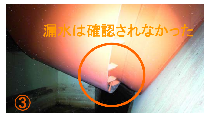
ベント管ベローズカバー下部
