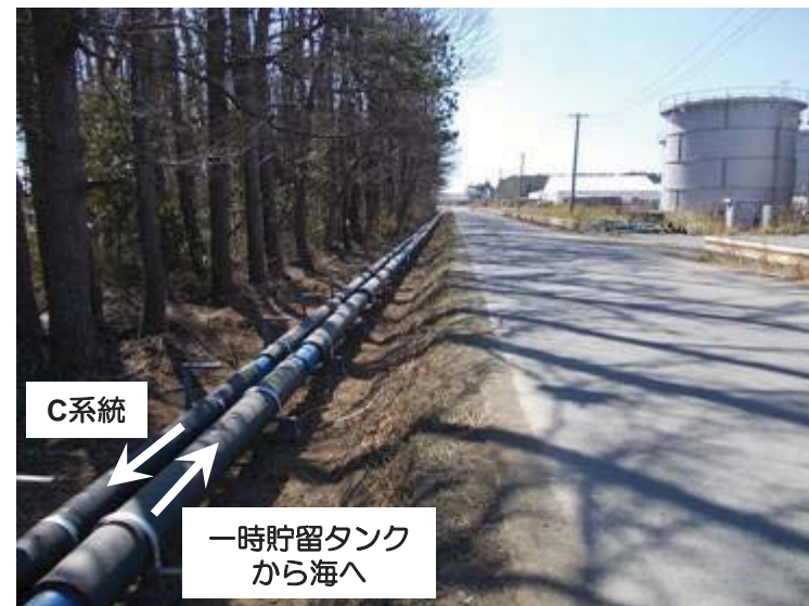
移送配管設置状況（C系統、一時貯留タンク～海）
