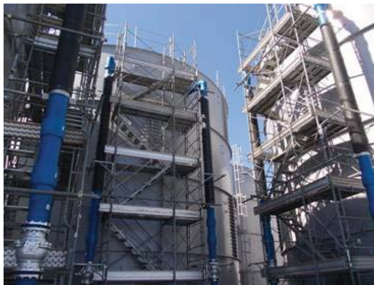
一時貯留タンク設置状況
