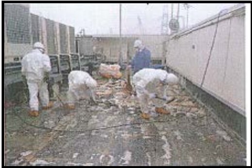
屋上コンクリート撤去
