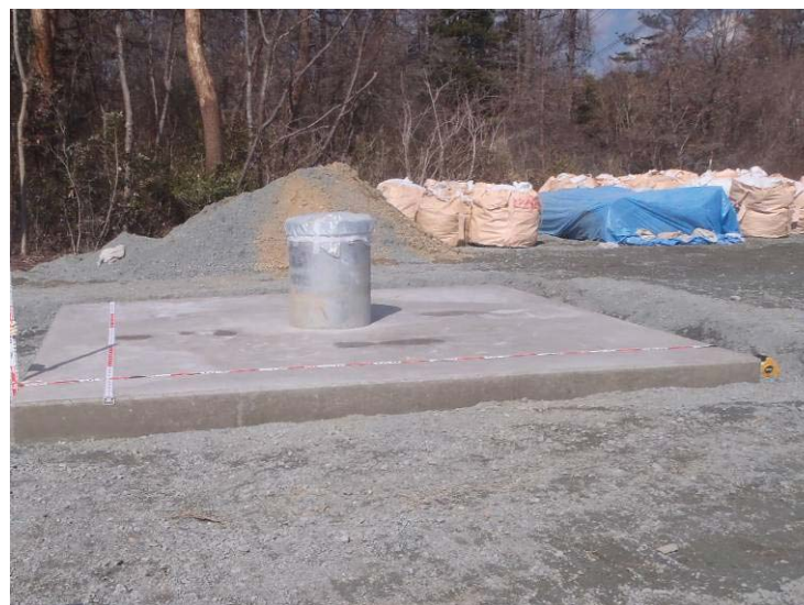
No.11揚水井（C系統）設置完了
