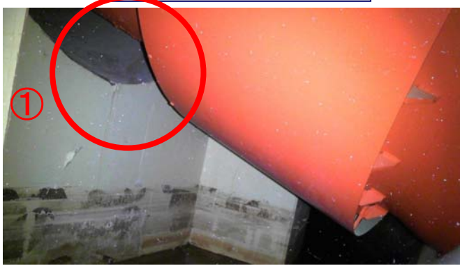
ベント管スリーブ端部
