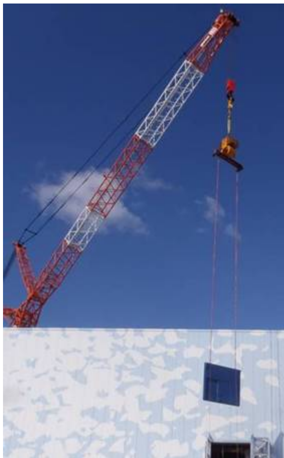
閉止パネル揚重中
