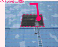
閉止パネル設置前
