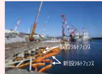
シルトフェンス交換の様子
