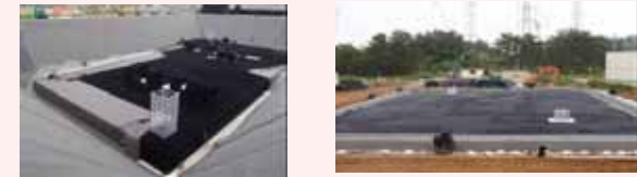
地下貯水槽設置状況
