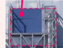
閉止パネル設置完了後
