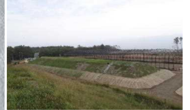
覆土式一時保管施設
