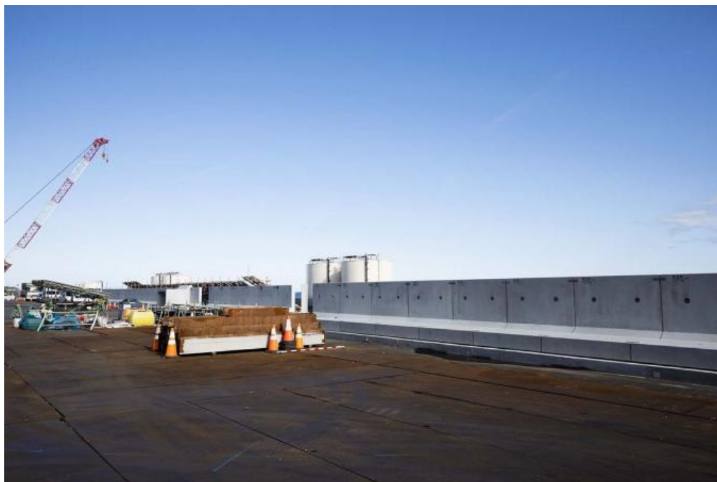
L型擁壁の据付状況
