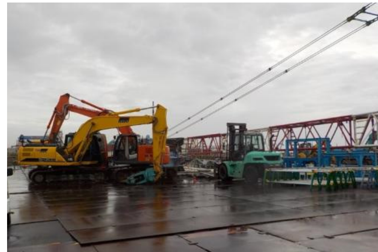
(350 t クレーン)
