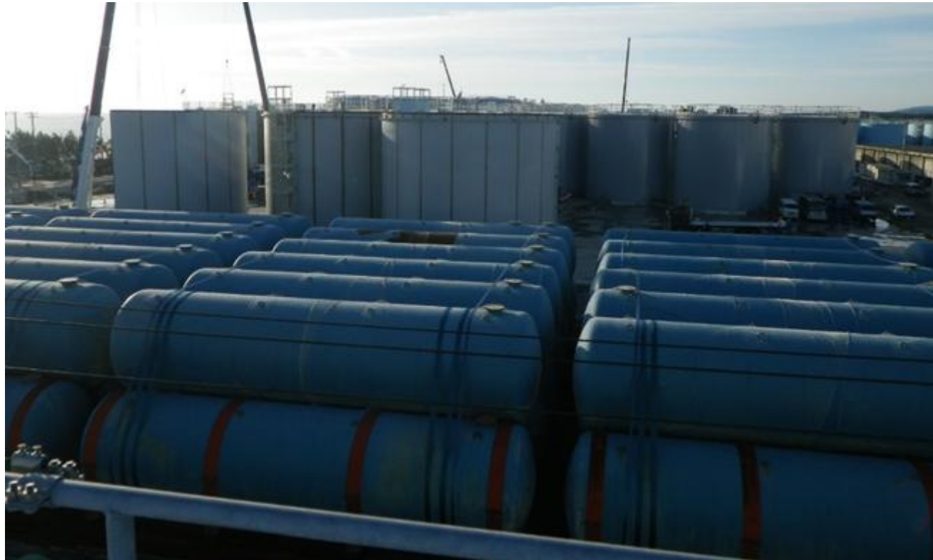
G1エリア タンク建設状況
