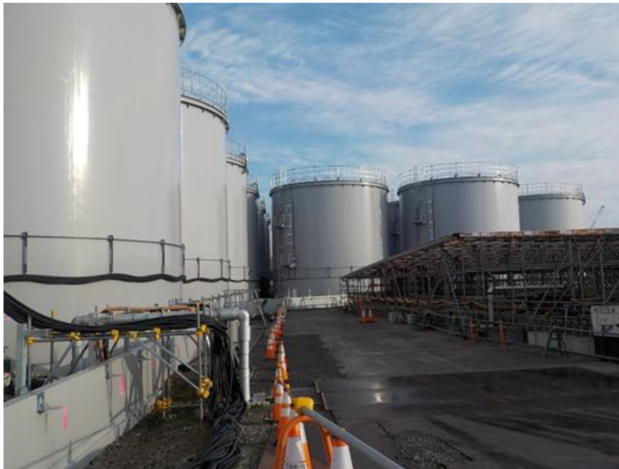
H 6 エリア タンク建設状況
