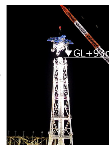
11ブロック解体後 (2020年2月1日)
