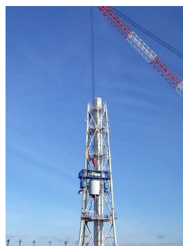
9ブロック解体後 (2020年1月11日)
