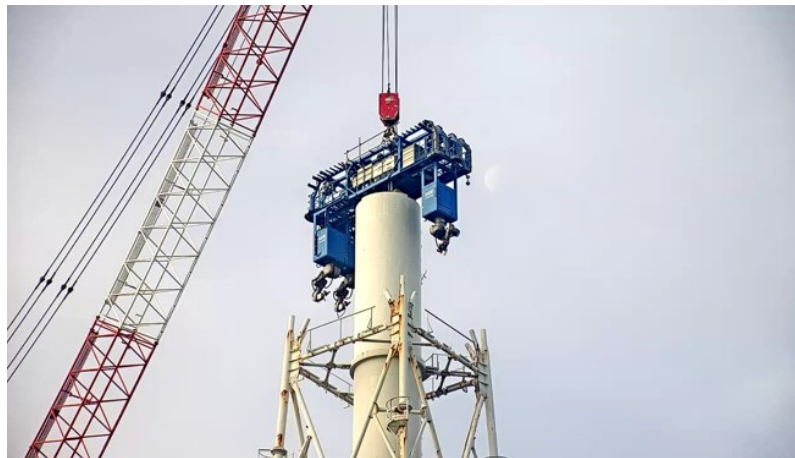
9ブロック目筒身解体作業(1月16日)
