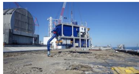
3号T/B上屋 ガレキ撤去中
