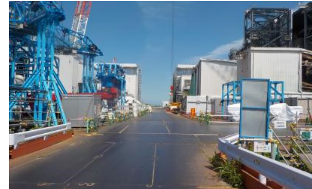
■ 2-3号間道路 状況写真
