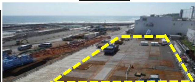
クレーンヤード整備 完了
