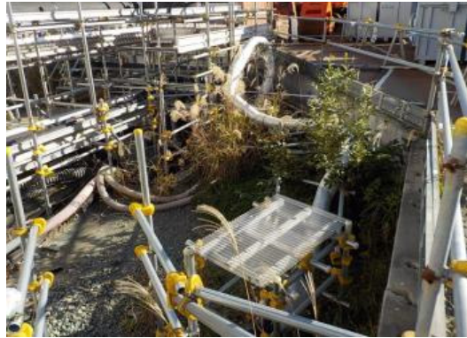
■ 1号機T/B北側 状況写真
