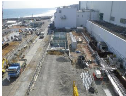
■ 3号機T/B海側 状況写真
