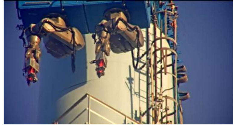
【写真⑥】 筒身切断状況 (9月18日)
