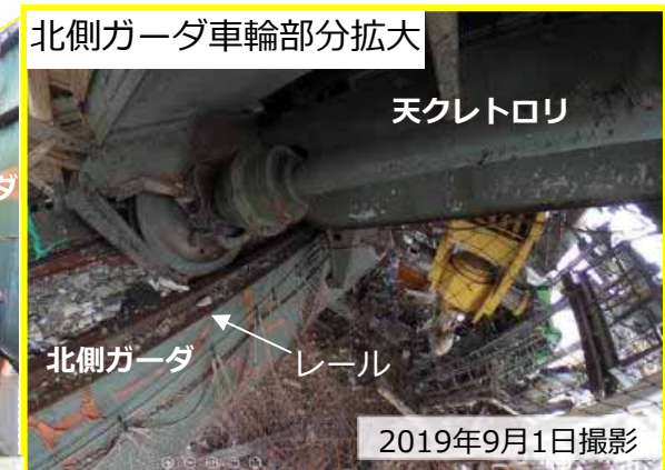
北側ガーダ車輪部分拡大
