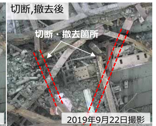
2019年9月22日切断状況 (左:切断前 右:切断、撤去後)
