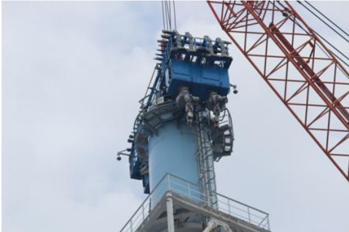
【写真①】切断作業状況・外側(9月1日)
