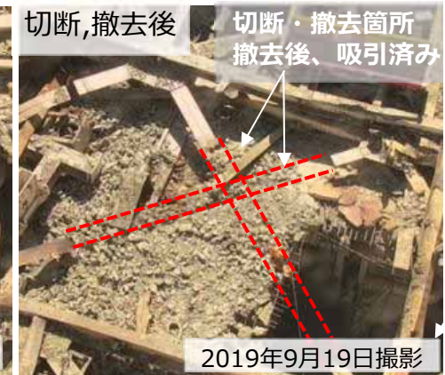
2019年9月19日切断状況 (左:切断前 右:切断、撤去後)
