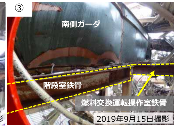
南側ガーダの接触状況
