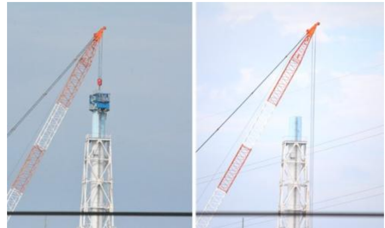
【写真④】解体前後の比較(9月1日)
