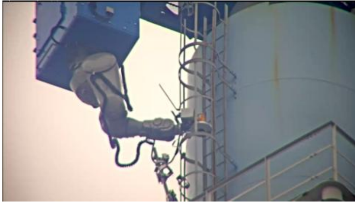
【写真⑤】 付属品切断状況(9月18日)
