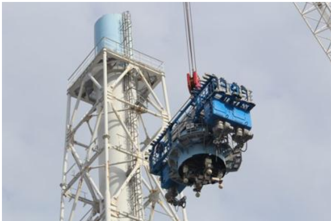
【写真③】吊り下ろし状況(9月1日)
