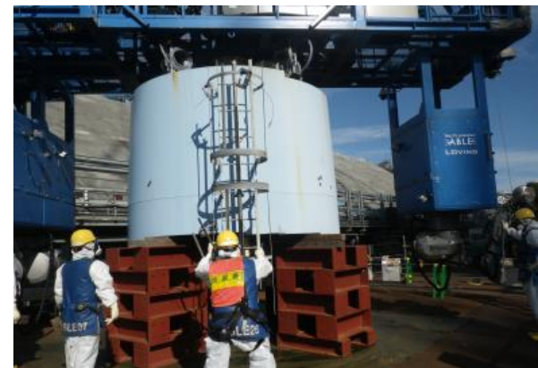
【写真⑧】 2ブロック目解体後 (9月26日)
