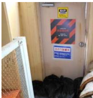
開口部への土のう設置例
