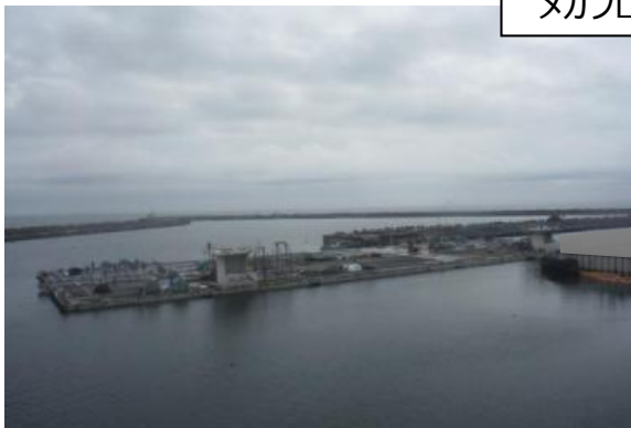
写真①: 1 - 4号機取水路開渠への移動
