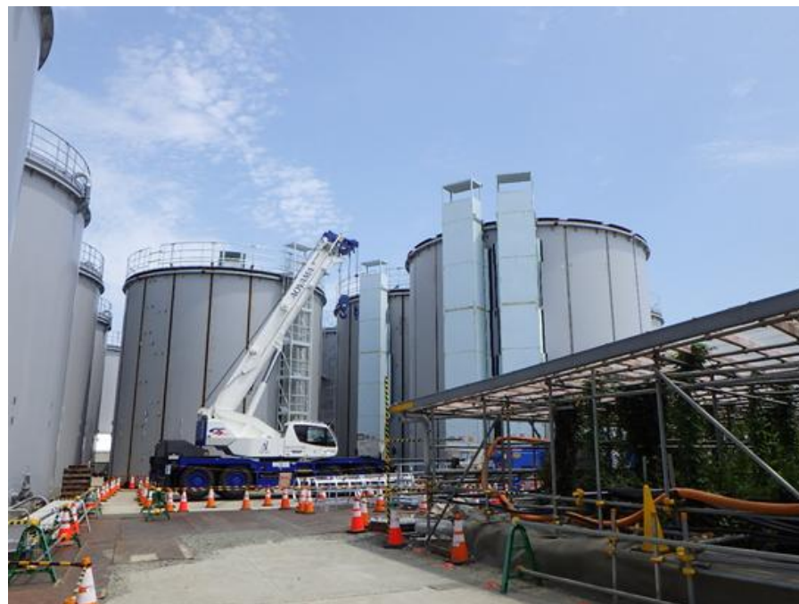
H6エリア タンク建設状況
