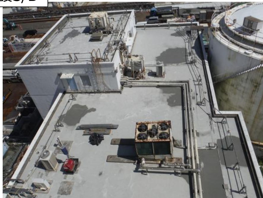
写真②:ガレキ撤去およびコンクリート打設状況 (9月17日時点)
