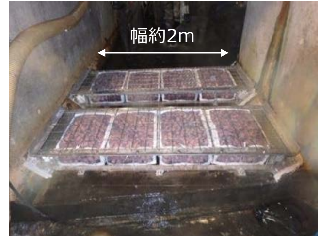
設置状況（下流側より撮影）
