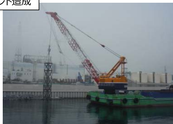
写真④: 起重機船による着底マウンド均し状況
