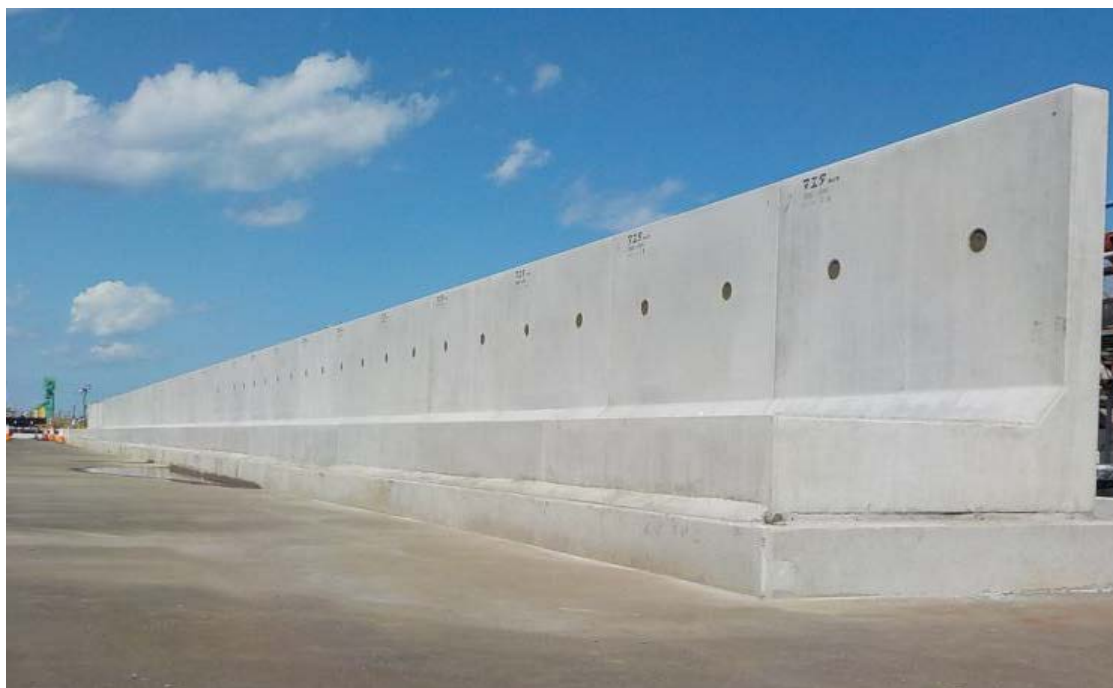
現地据付状況 (9月25日撮影)
