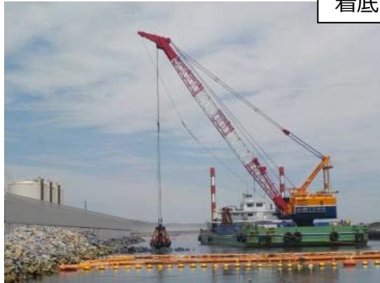
写真③: 起重機船による人工地盤材料投入状況
