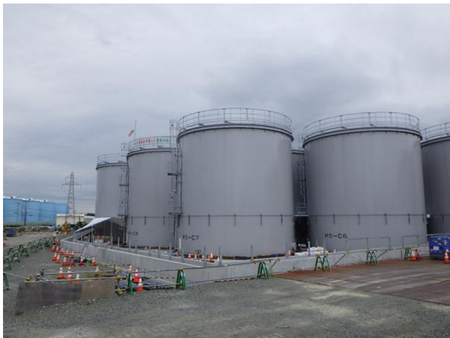
H5エリア タンク建設状況
