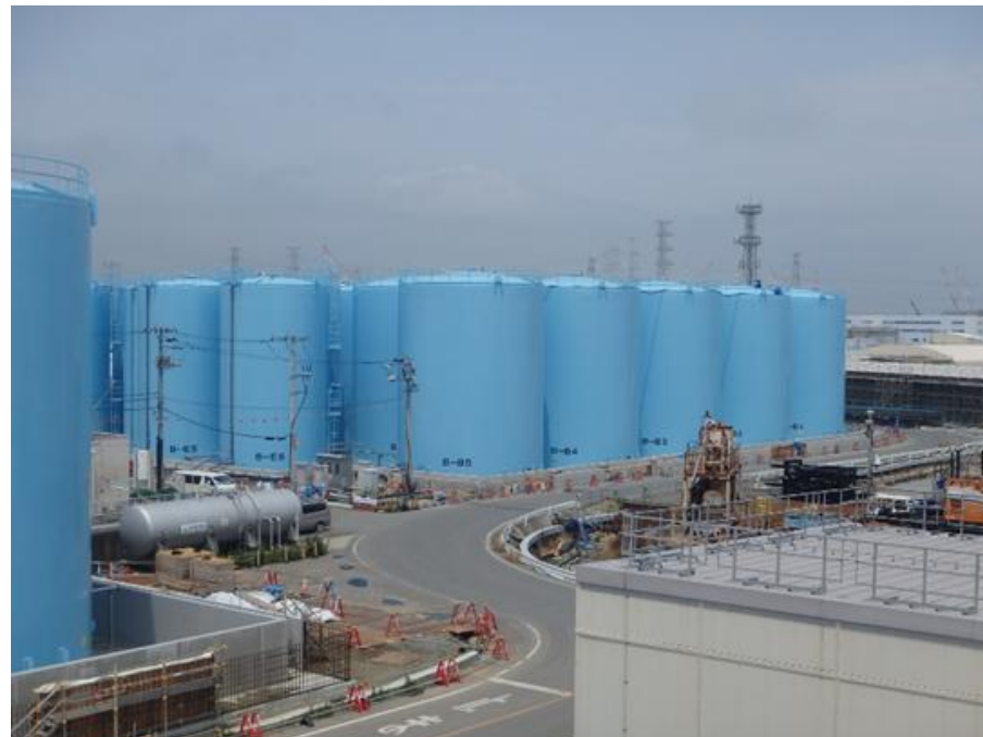
Bエリア タンク建設状況
