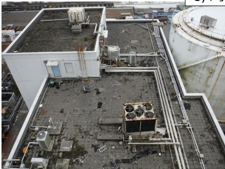
写真①:ガレキ撤去前
