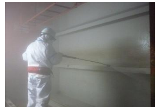
写真⑥: 内部除染状況
