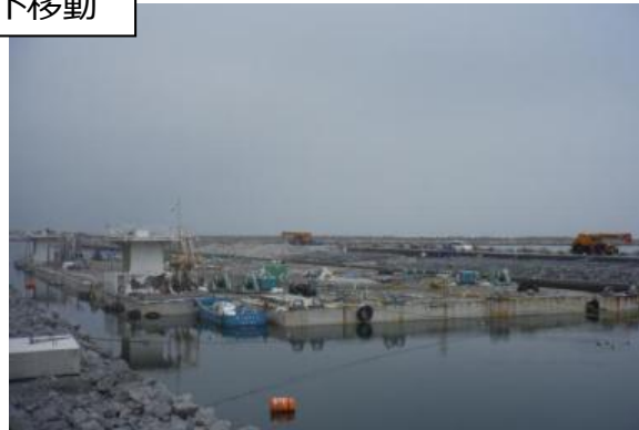
写真②: 1 - 4号機取水路開渠への移動完了
