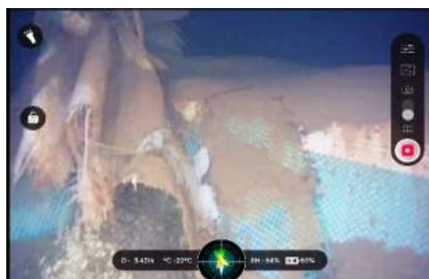
破損している土嚢
