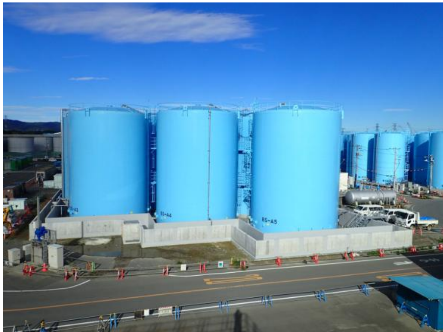
B南エリア タンク建設状況
