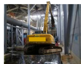
遠隔解体重機
