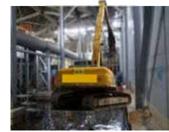
遠隔解体重機
