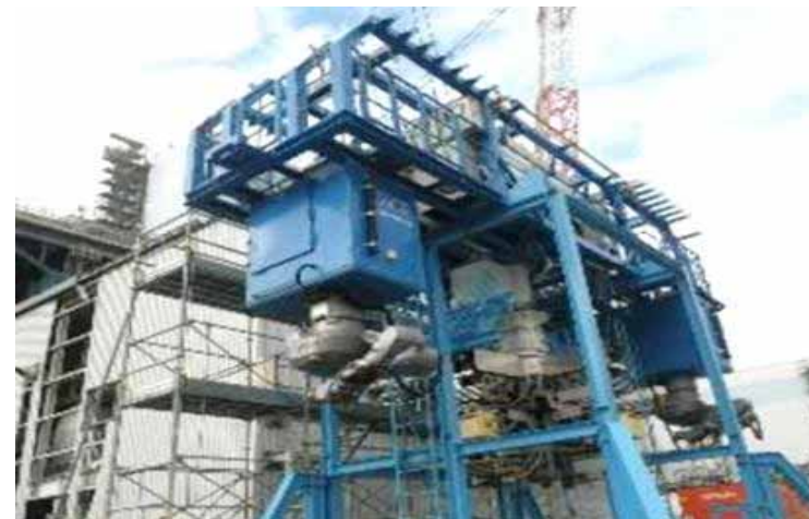
解体装置写真
