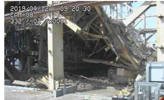
小ガレキ撤去状況
