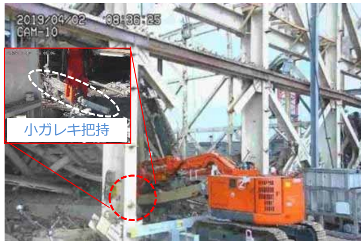
遠隔操作重機による作業状況
