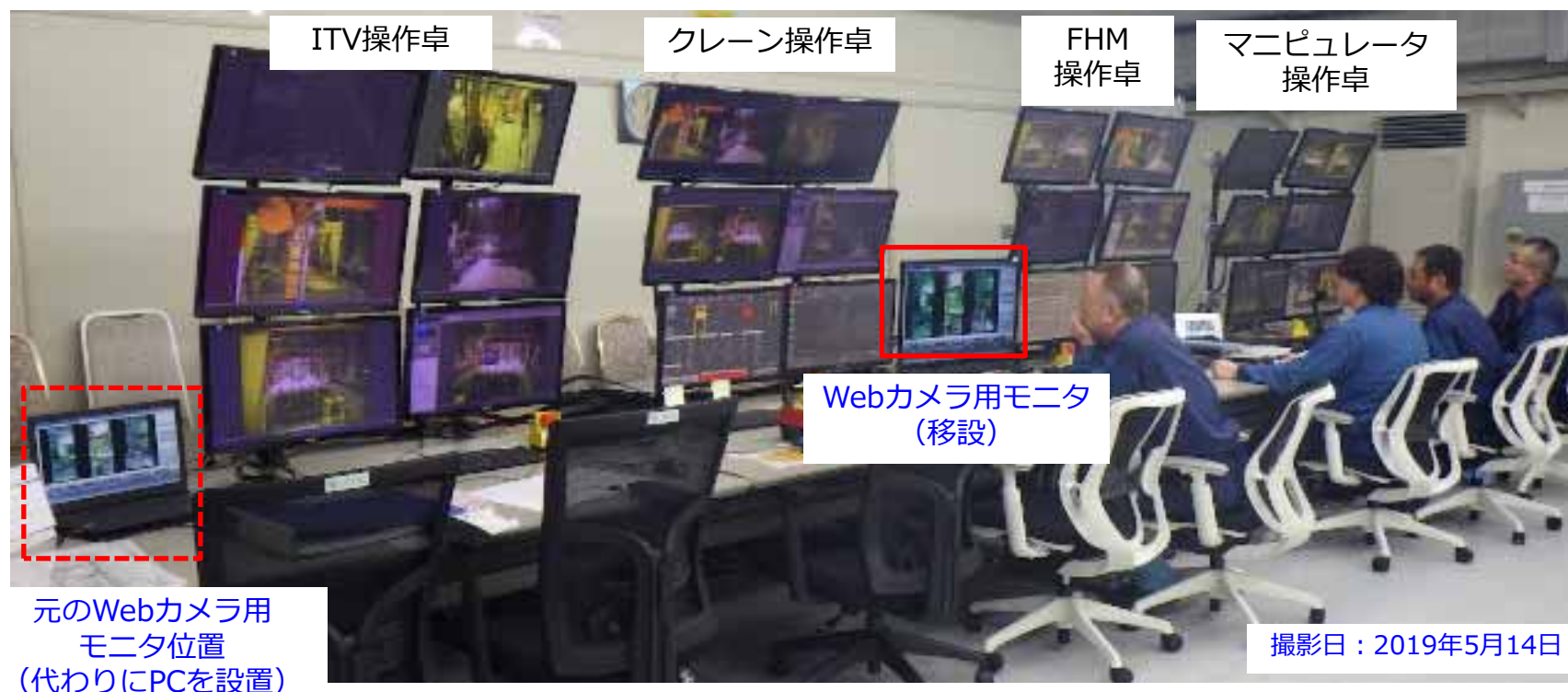
遠隔操作室操作卓等配置
