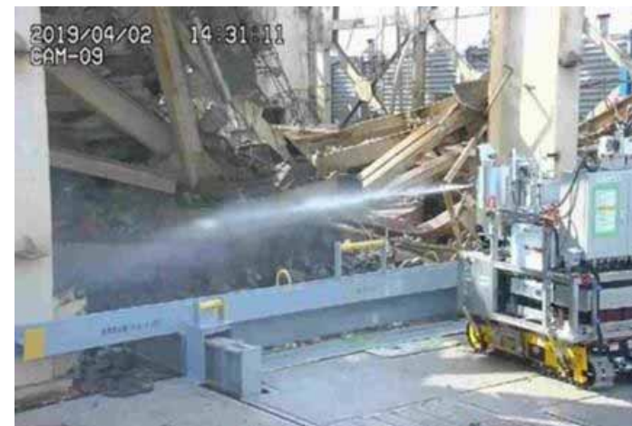
飛散防止剤散布状況
