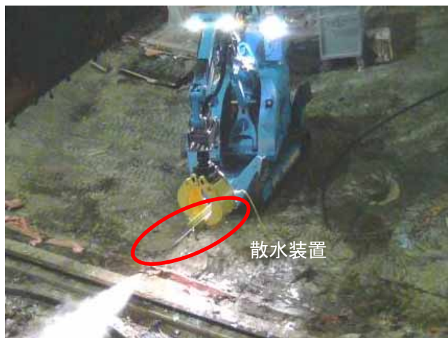
①散水状況（ダスト抑制対策）
