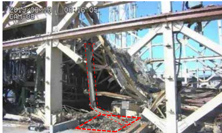
小ガレキ撤去前
