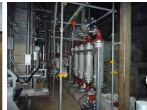
3TB下屋 設置状況
