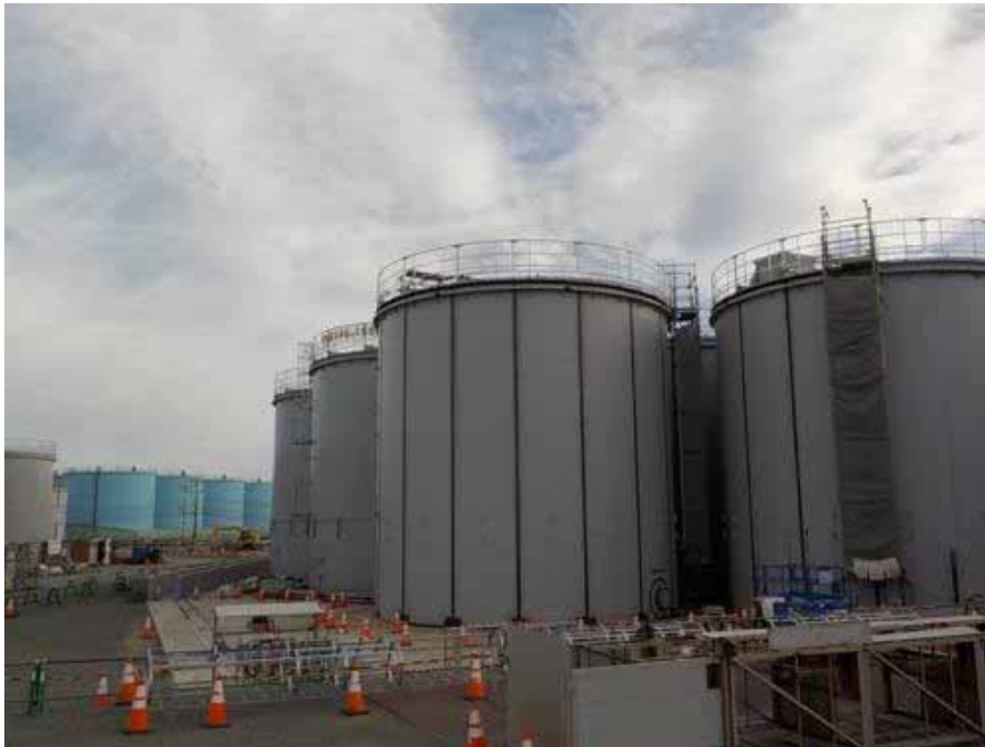
H5エリア タンク建設状況
