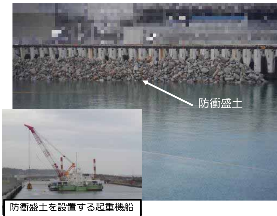
【防衝盛土設置工事の様子】
