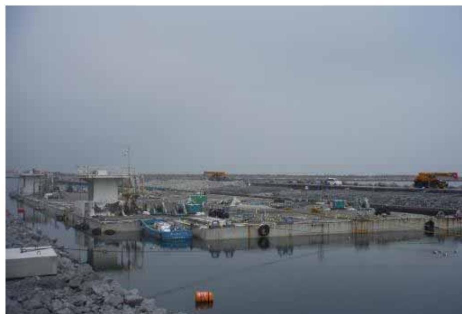
写真②: 1 - 4号機取水路開渠への移動完了 2019年5月16日
