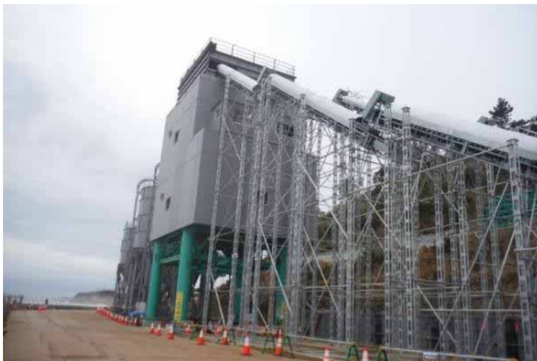
写真③：製造プラント全景
