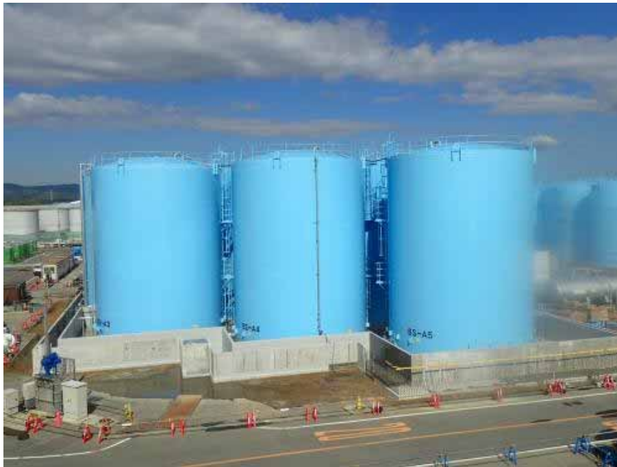
B南エリア タンク建設状況
