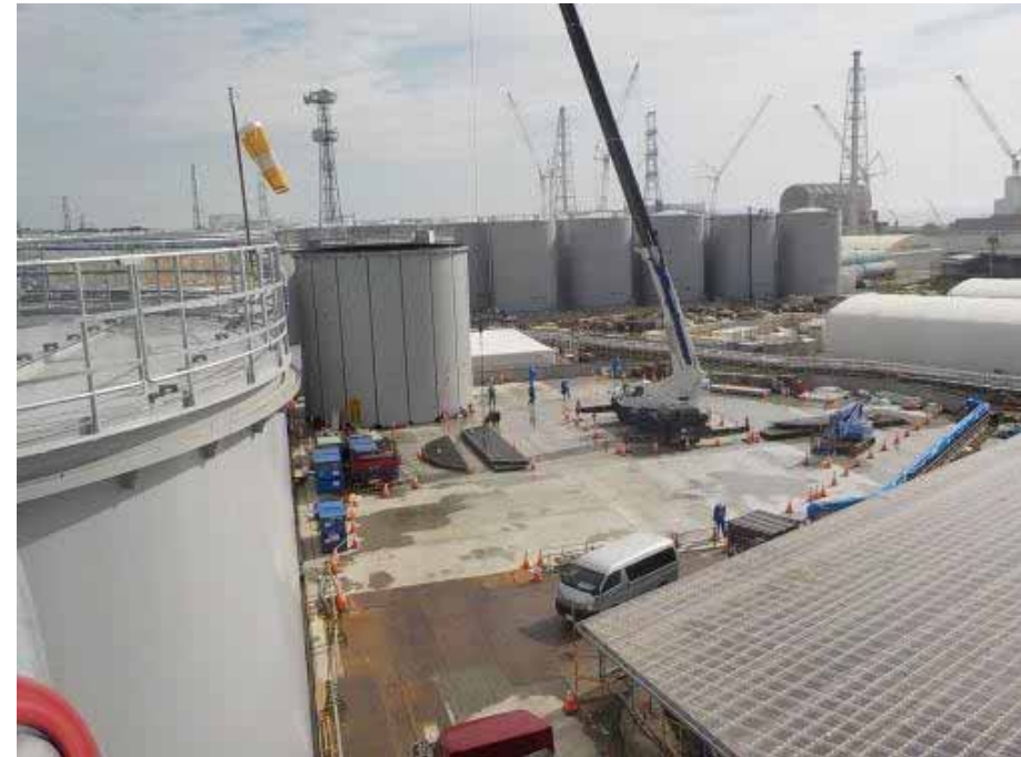
H6エリア タンク建設状況
