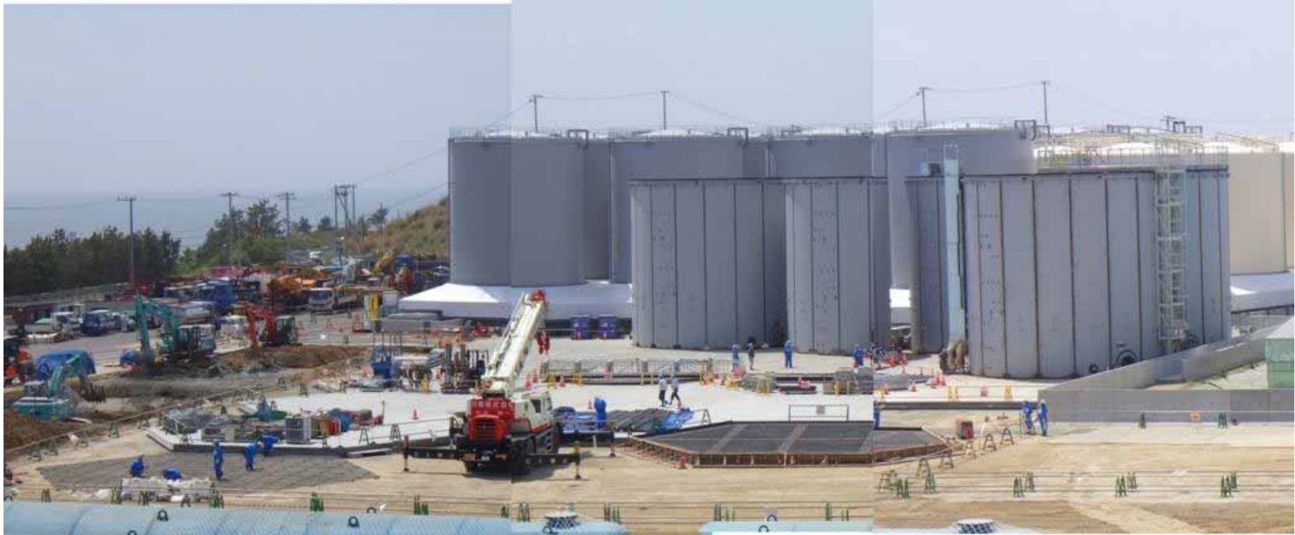
G1エリア タンク建設状況
