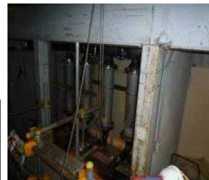
2TB下屋 設置状況
