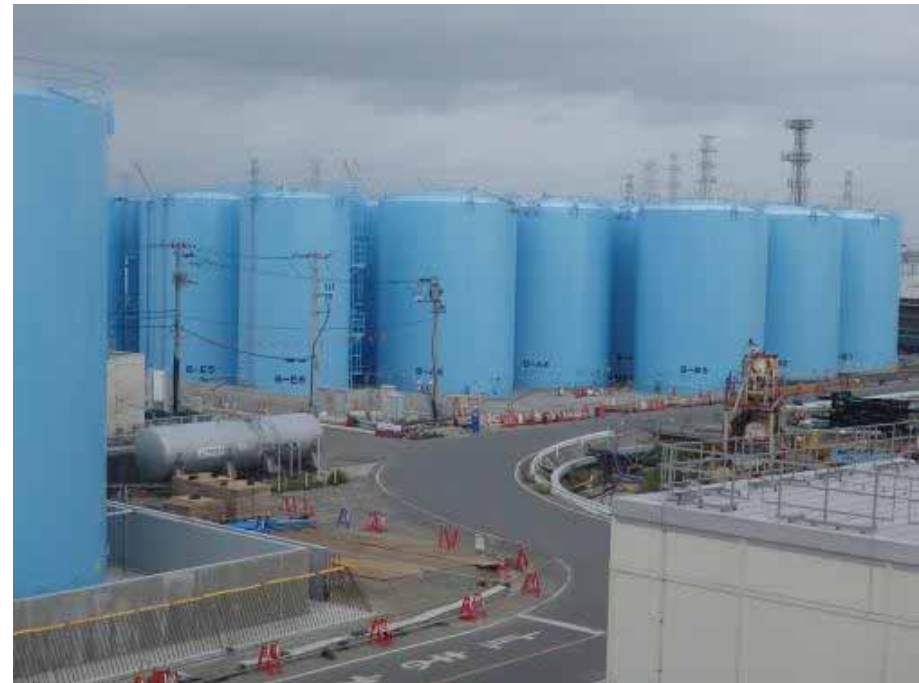
Bエリア タンク建設状況
