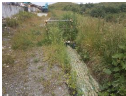
写真5-1 土側溝 (作業前)
