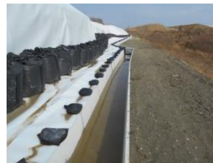
写真5-2 側溝 (作業完了)
