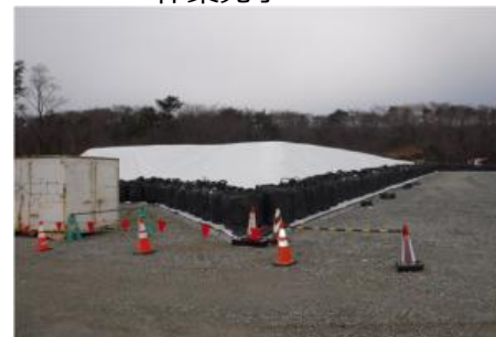
写真4 養生エリア④ 作業完了
