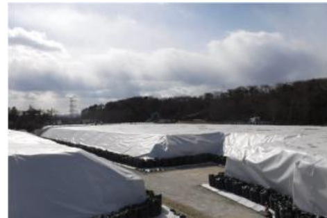
写真3 養生エリア③ 作業完了
