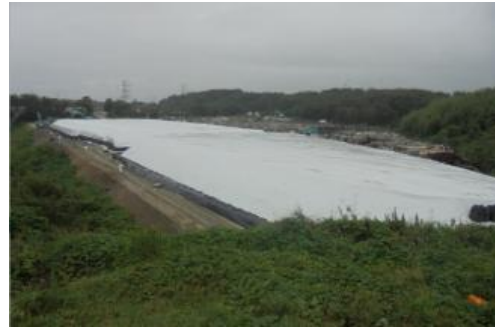
写真2 養生エリア①② 作業完了
