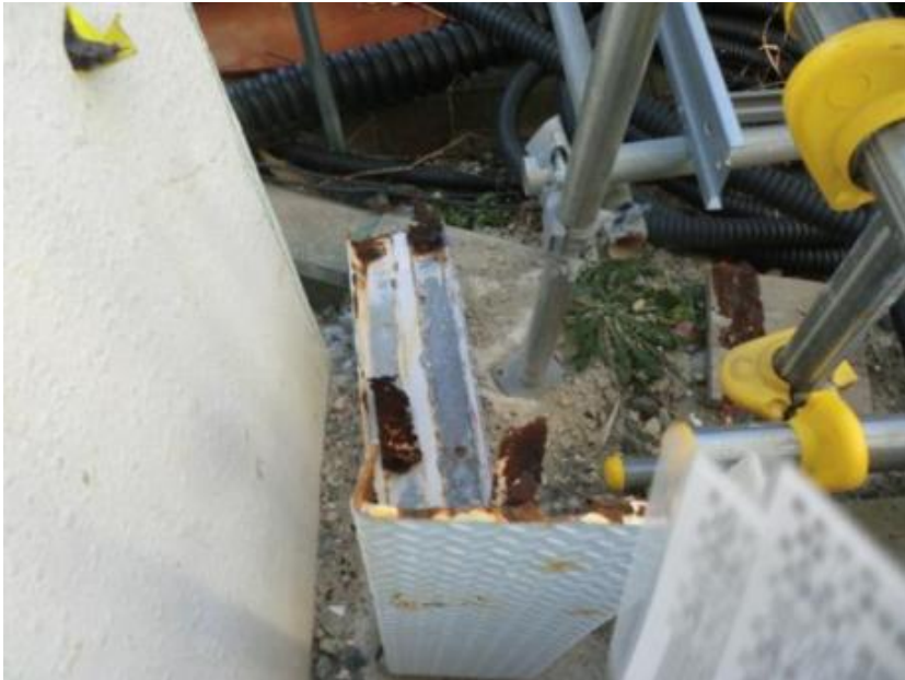
落下した足場
