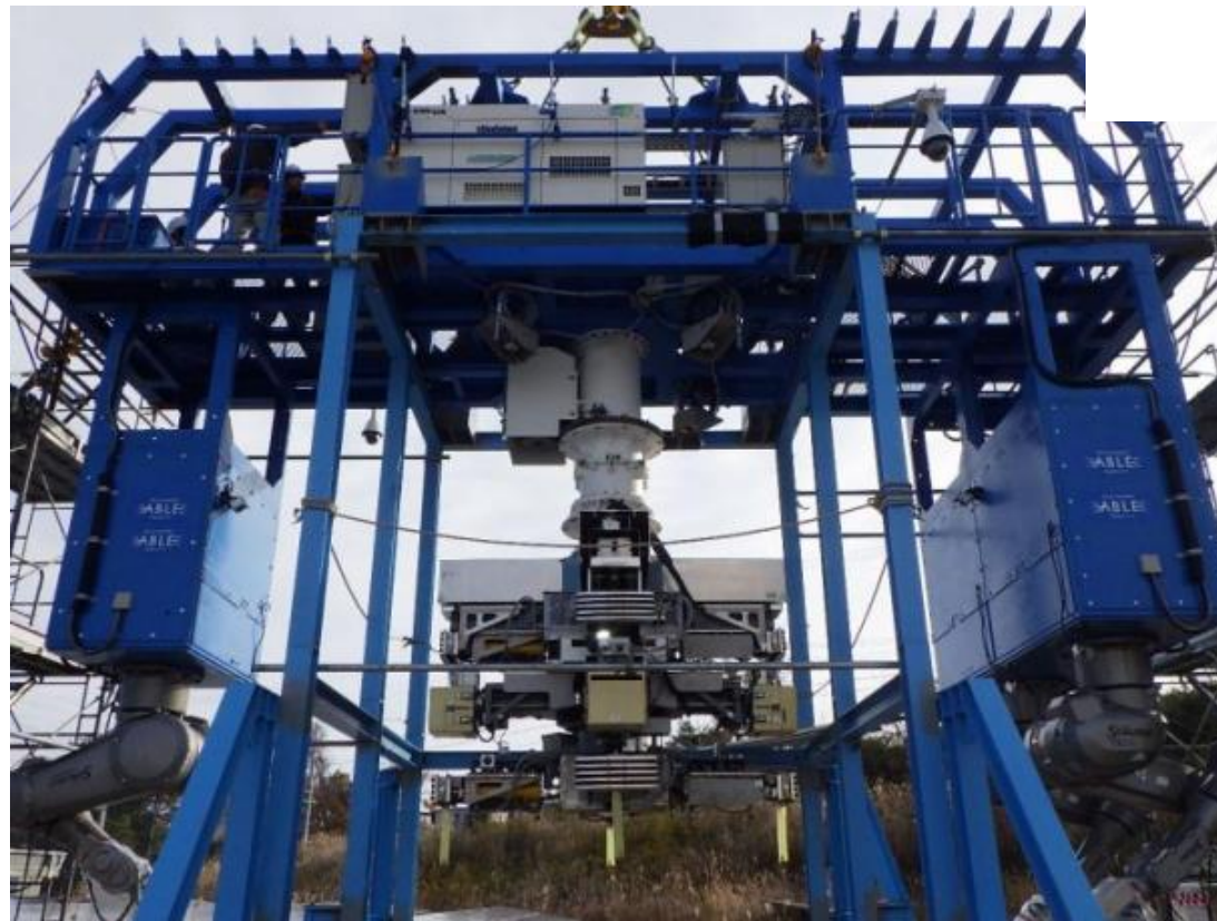
挿入ガイド取付状況
