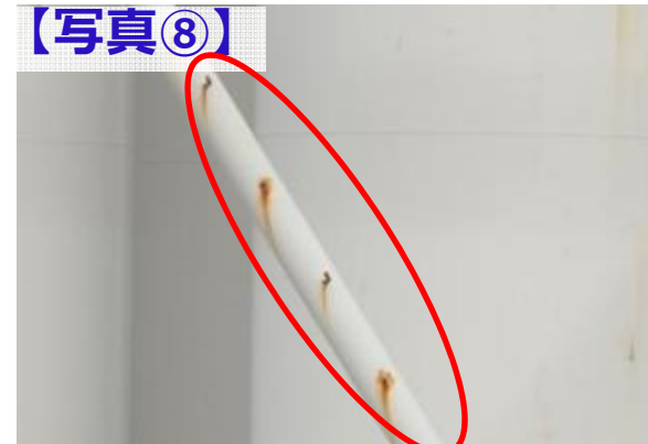
劣化が疑われるステップ 南面 地上32m付近
