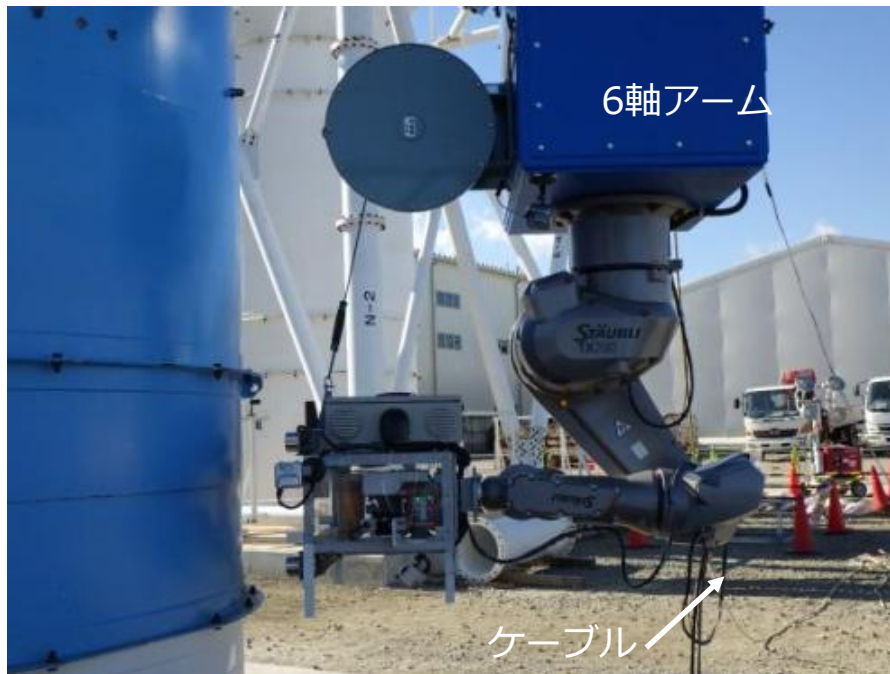
6軸アームロボットケーブル保護材 設置前
