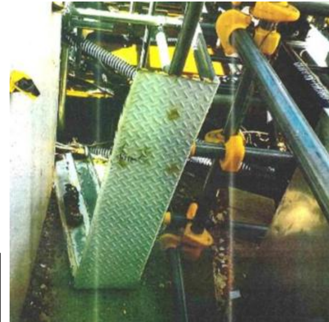
落下した点検用の足場
