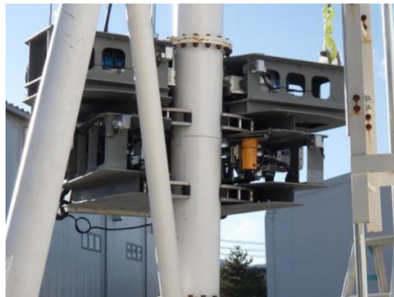
主柱切断作業の状況
