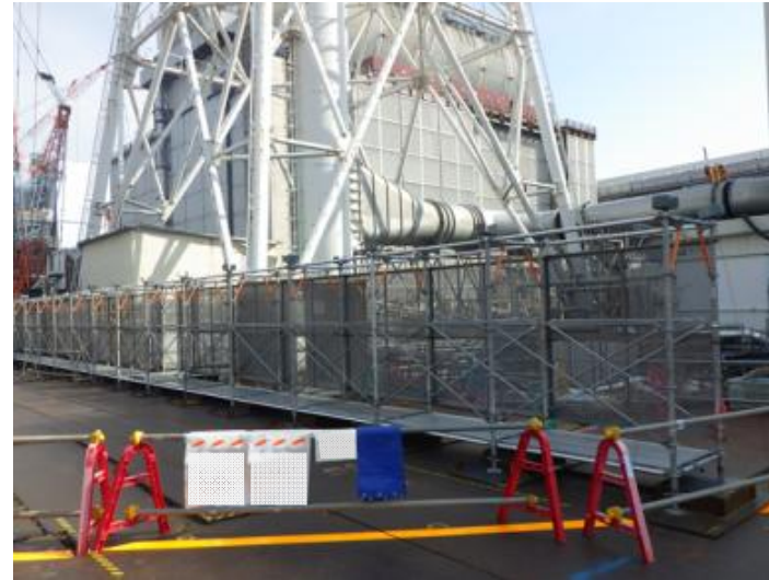
3/4号機排気筒：西側②
