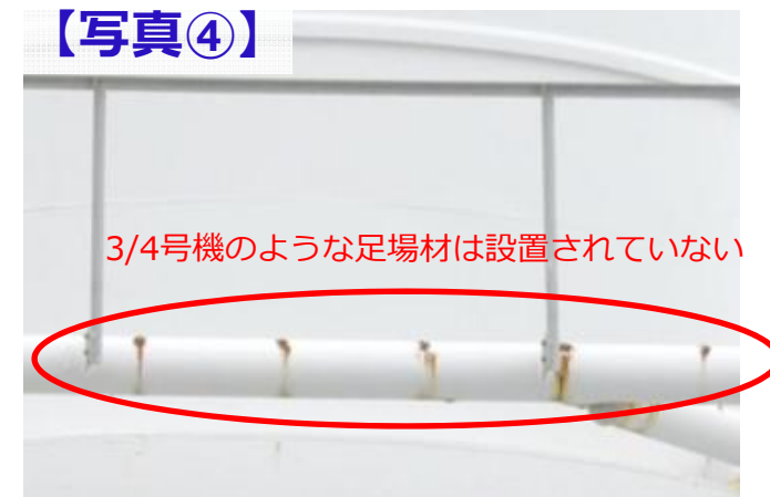
5/6号機の鉄塔 南面 地上76m付近
