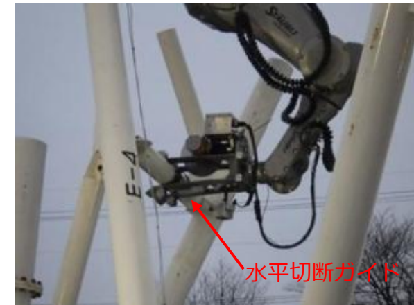
鉄塔水平材切断状況
