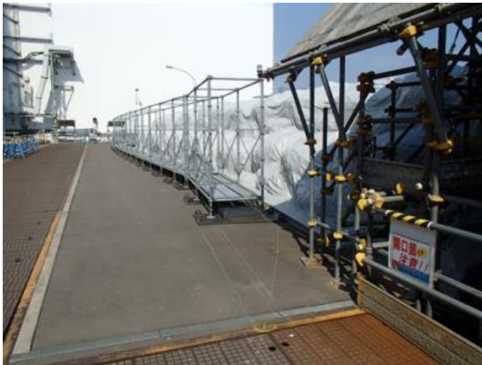
タービン建屋集中排気筒：東側
