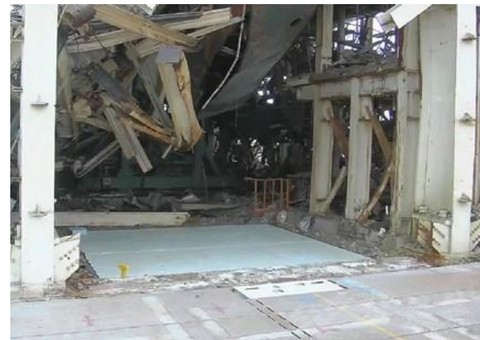
機器ハッチ養生カバー設置後
