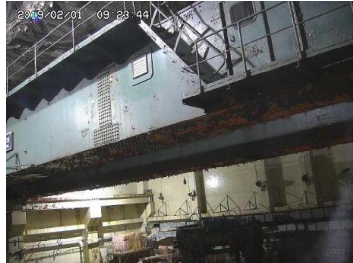
【天井クレーン】
