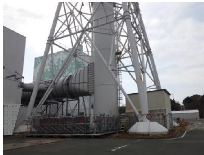
5/6号機排気筒：北側
