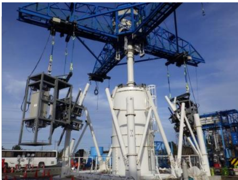
斜材切断の状況
