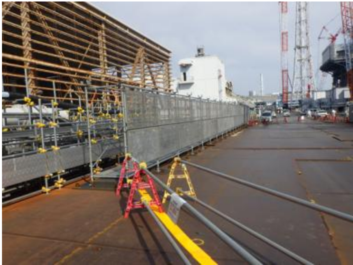
3/4号機排気筒：西側①
