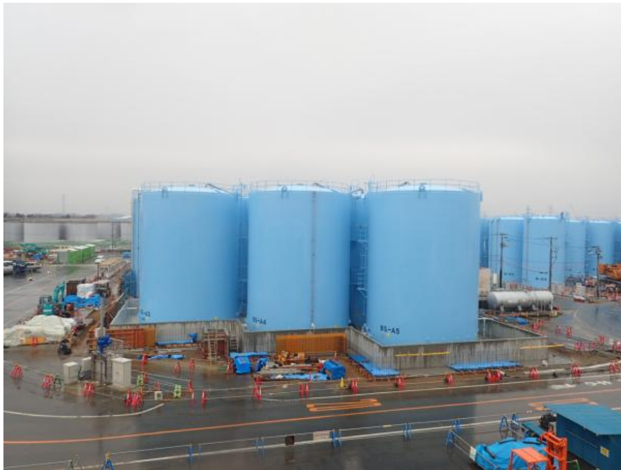
B南エリア タンク建設状況
