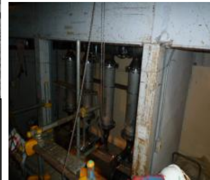
2TB下屋 設置状況
