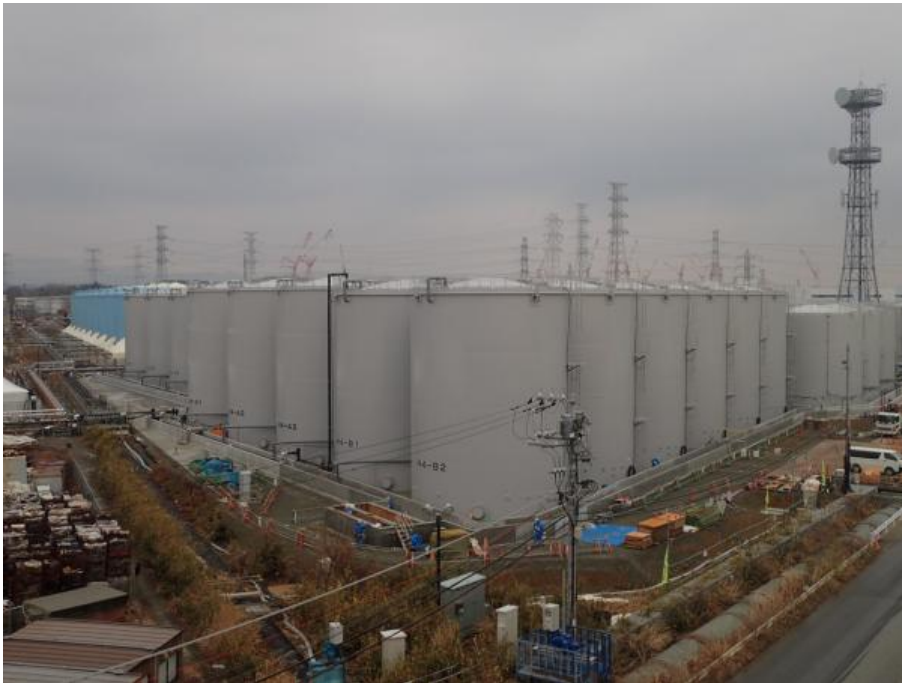
H 4 南エリア タンク建設状況
