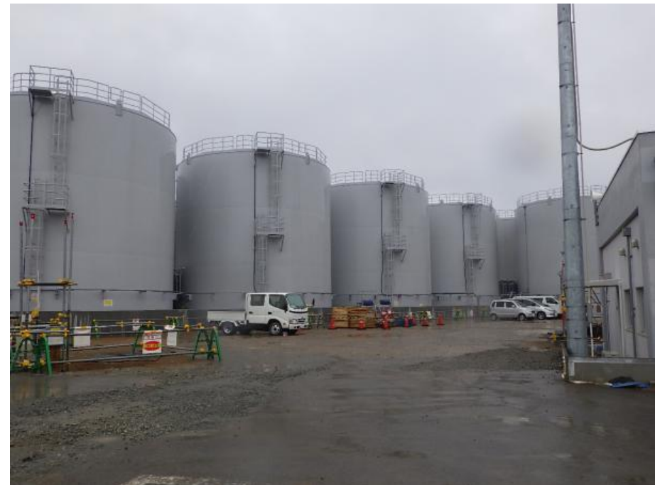
H 4 北エリア タンク建設状況
