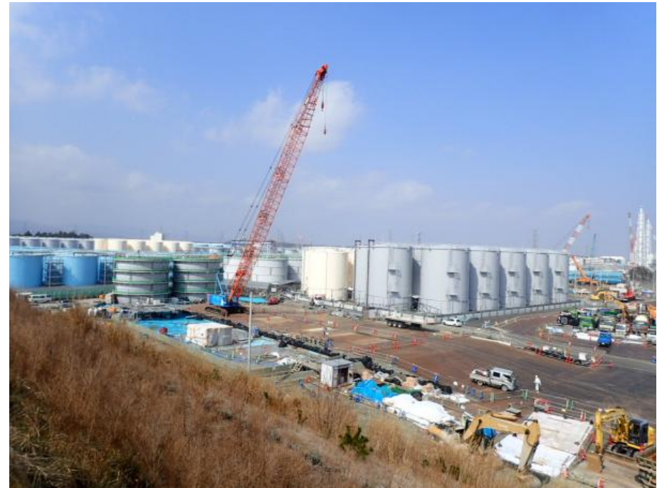
G 4 南エリア タンク解体状況
