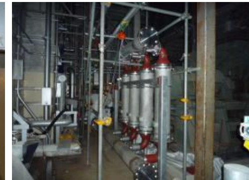
3TB下屋 設置状況
