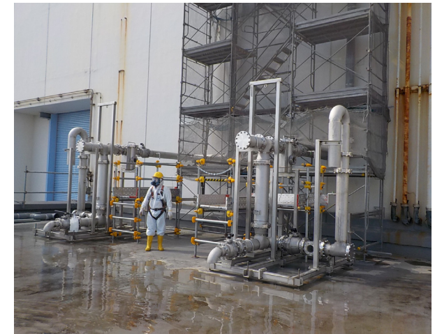
4号機タービン建屋上屋 浄化材
