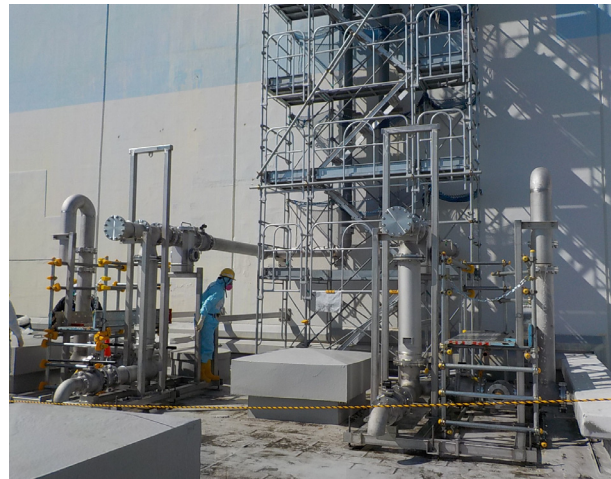
2号機タービン建屋上屋 浄化材
