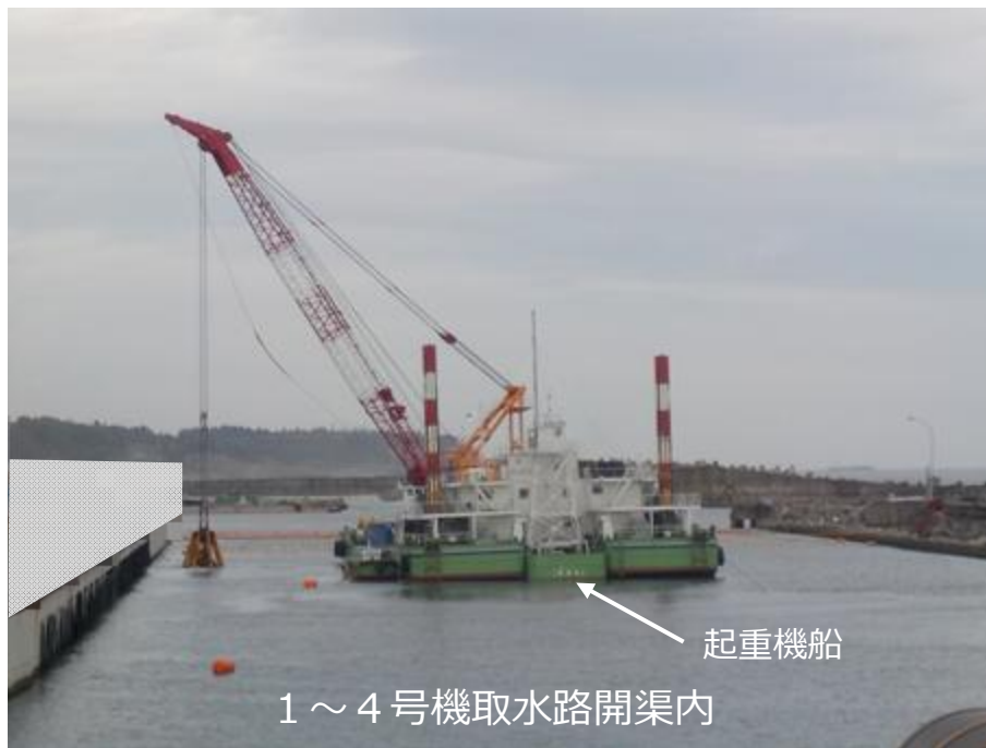
写真①：捨石投入状況
