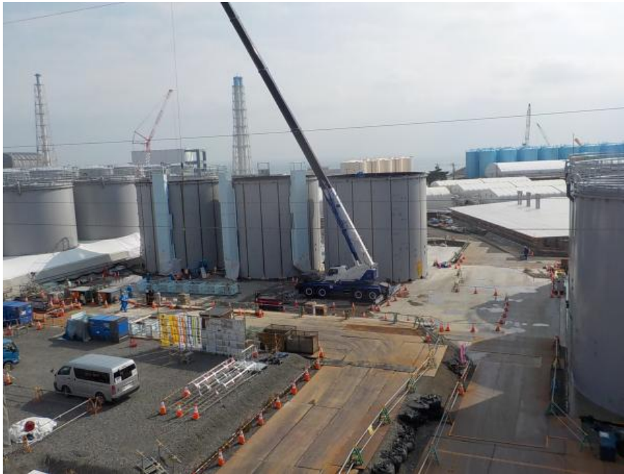
H 6 エリア タンク建設状況
