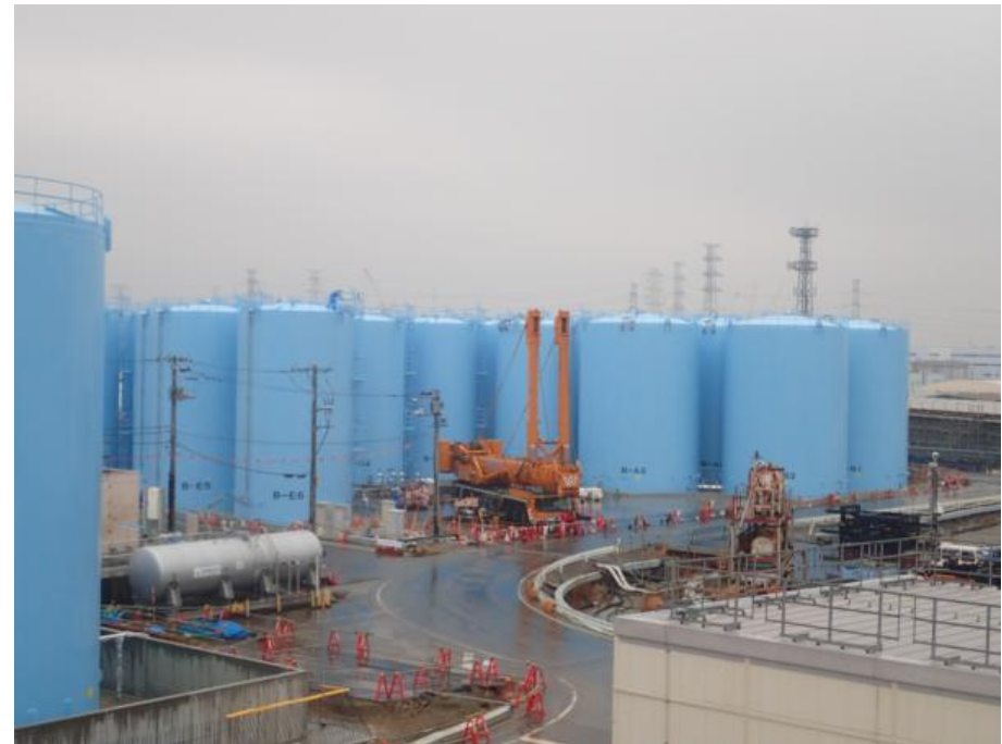
Bエリア タンク建設状況
