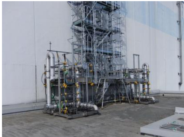
1号機タービン建屋上屋 浄化材
