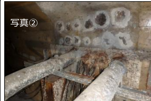
2号機取水電源ケーブルトレンチ貫通箇所 止水状況（写真②）、充填状況（写真③）
