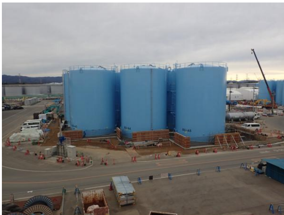
B南エリア タンク建設状況
