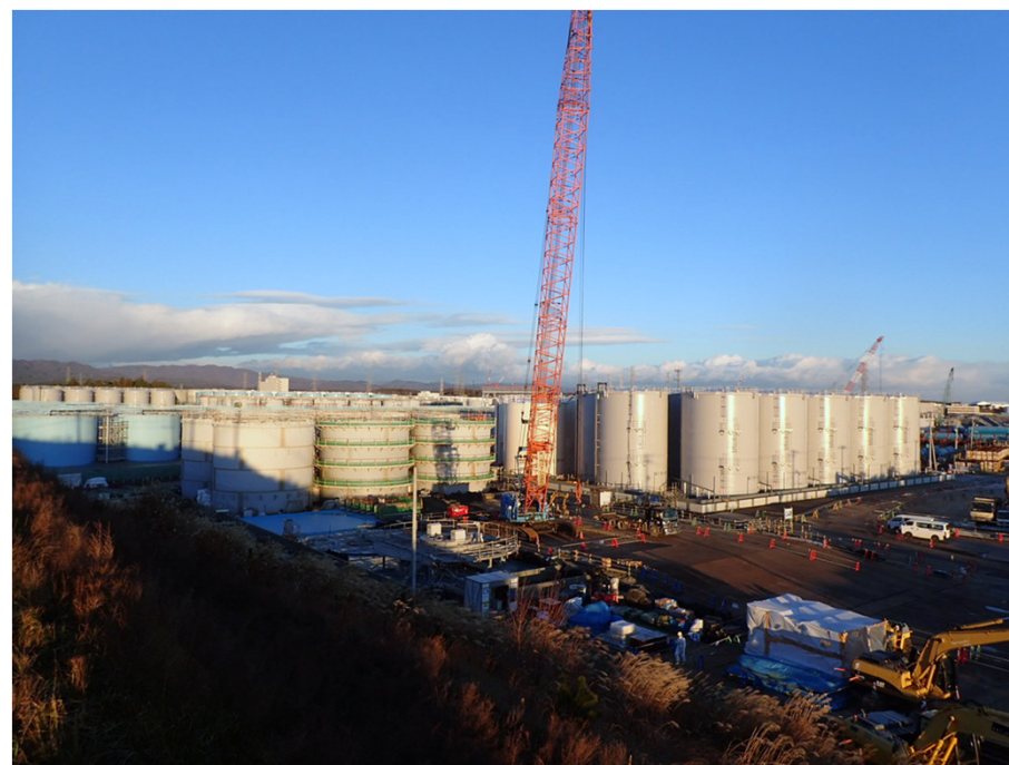
G 4 南エリア タンク解体状況
