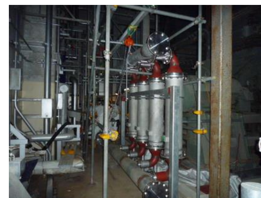
3TB-1 設置状況
