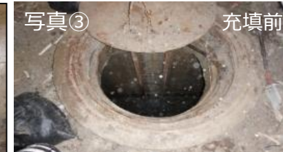
1号機共通配管トレンチ貫通箇所 止水状況
