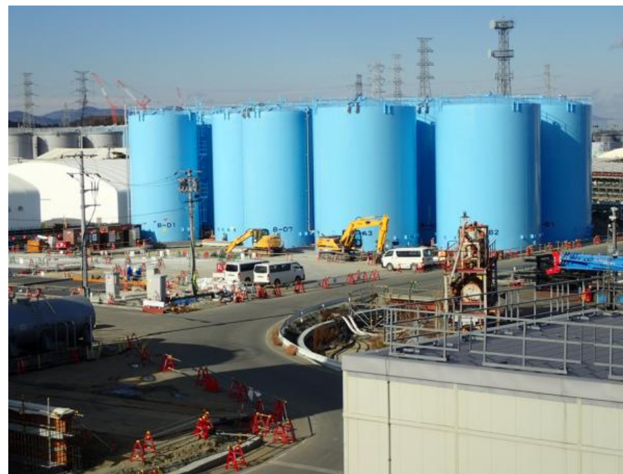
Bエリア タンク建設状況
