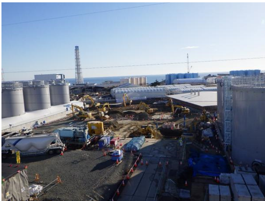
H 6 エリア タンク建設状況
