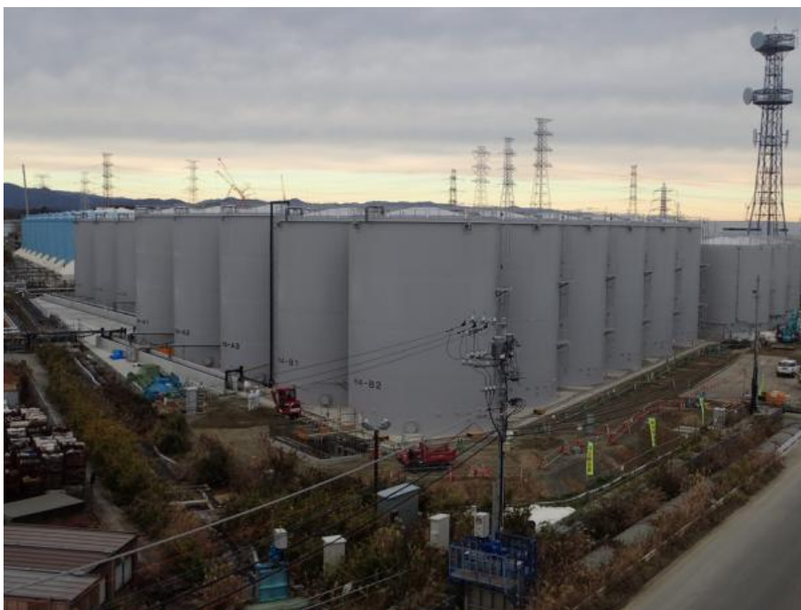
H 4 南エリア タンク建設状況
