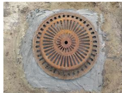
②ルーフトレン改修完了
