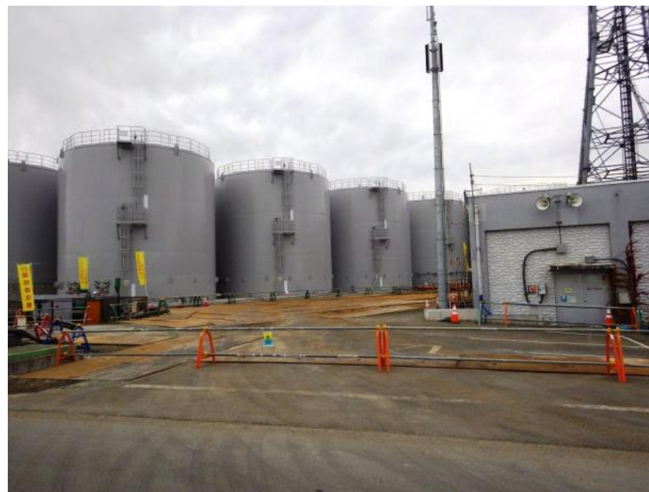
H 4 北エリア タンク建設状況
