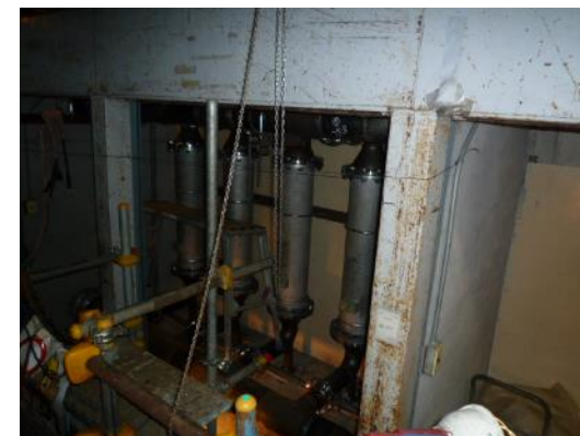
2TB-1 設置状況
