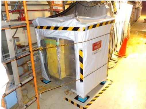
小型ミュオン測定装置※1 (3号機タービン建屋1階) (約1m×1m×高さ1.3m)
