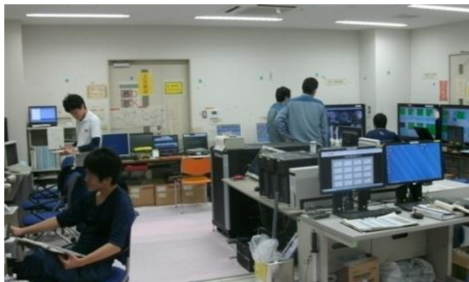
集中監視システムの設置前 （個別の監視機器で監視）
