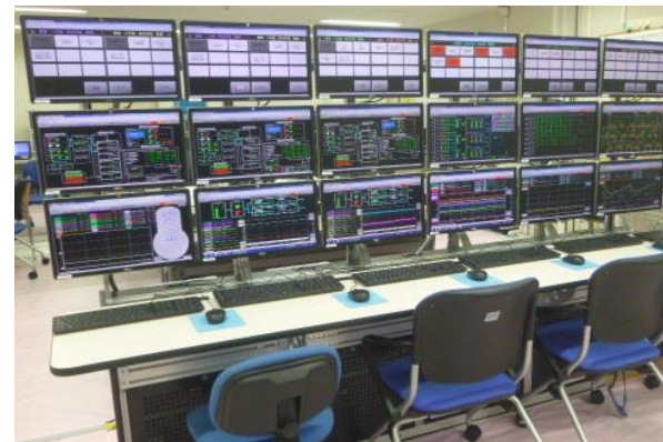
集中監視システム設置完了 （2015年2月）
