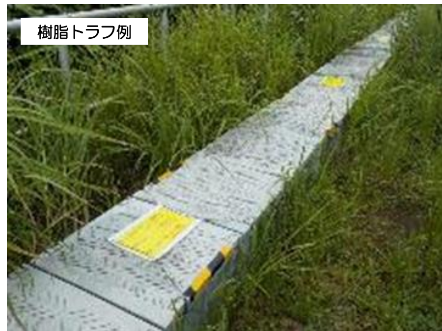
トラフ化・防護板設置による電路強化
