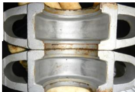
① 配管継手ハウジング内面 目視点検状況 (亀裂、腐食等の異常なし)
