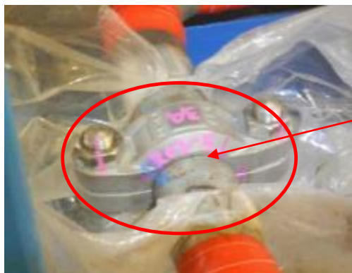
ブースターポンプ出口配管継手部
