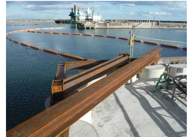
【コーナー部における杭頭結合状況】
