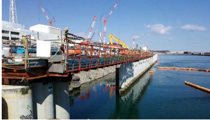
〈鋼管矢板打設前〉
