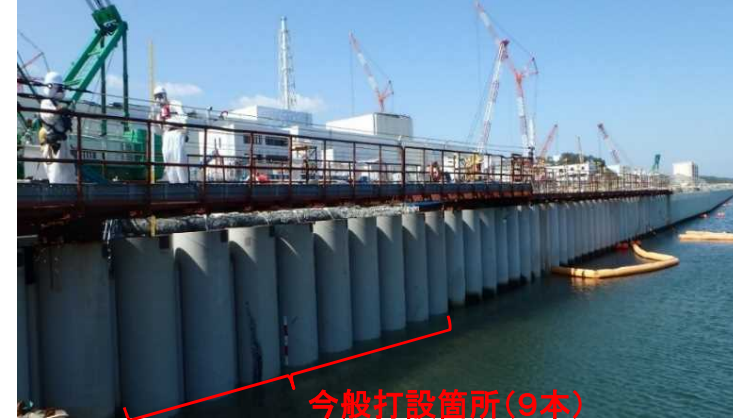
〈鋼管矢板打設完了後〉
