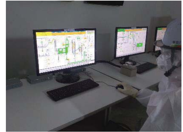
制御室 試験作業状況
