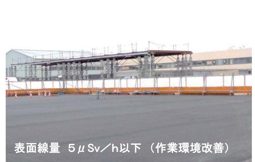
【写真②(35m盤)】北側エリア:免震棟前舗装後
