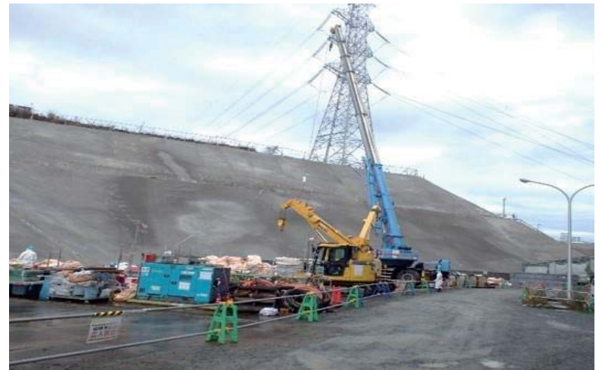
【写真④(35m盤)】1～4号法面:モルタル吹付施工後
