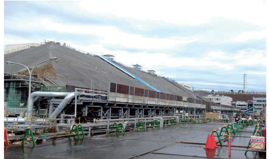
【写真④(35m盤)】1～4号法面:モルタル吹付施工後
