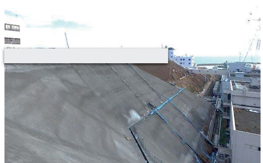
【写真①(35m盤)】北側エリア:モルタル吹付施工後
