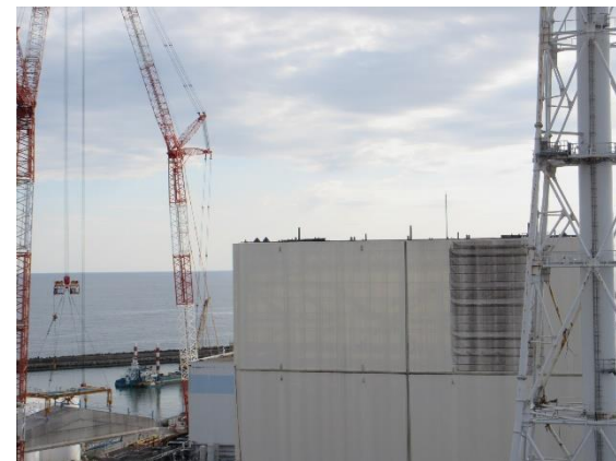
1号機建屋山側より撮影 (屋根パネル取り外し作業後)
