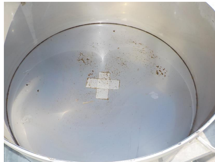
図 水盤の状況（西側より撮影）
