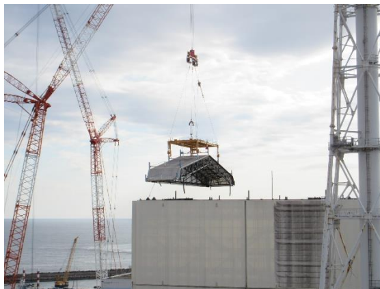
1号機建屋山側より撮影 (屋根パネル取り外し作業中)
