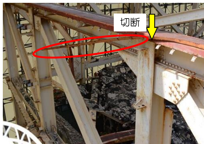
支障となる鉄骨等の例
