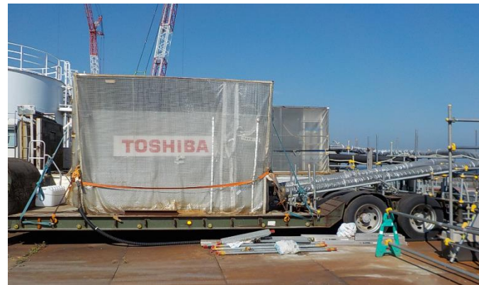
モバイル式処理装置
