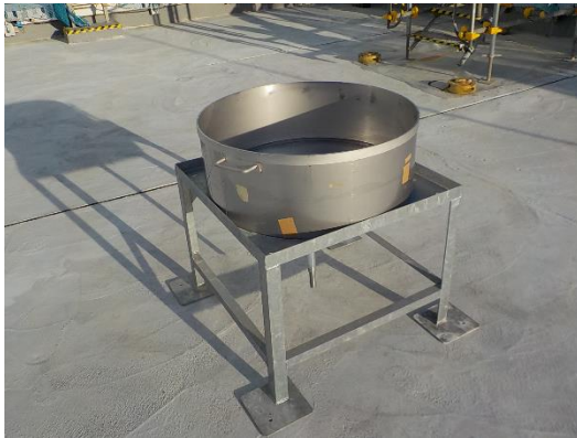
水盤の設置状況
