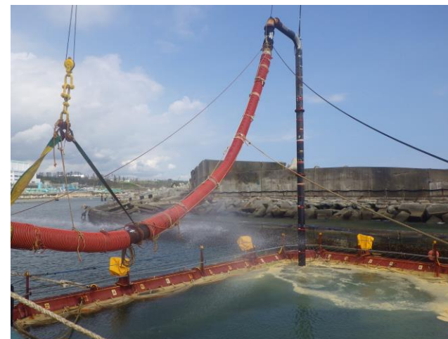
根固石の被覆イメージ
