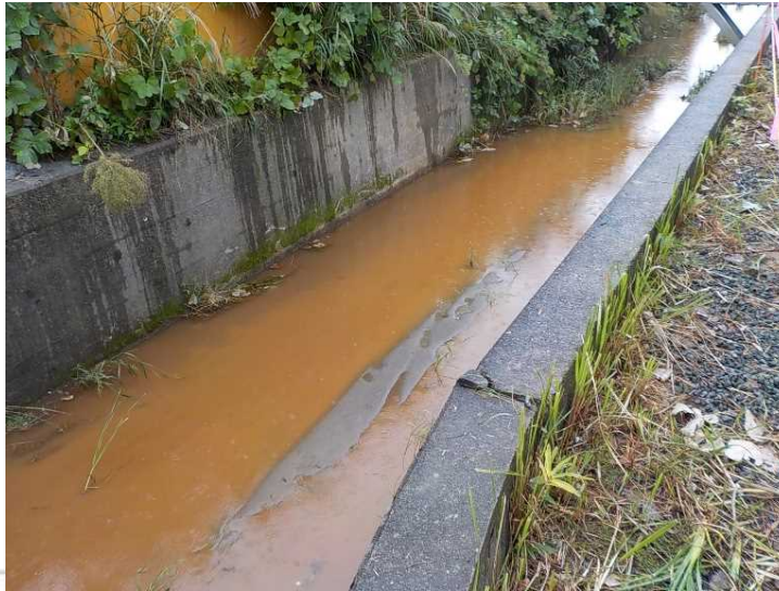
上流部清掃予定箇所
