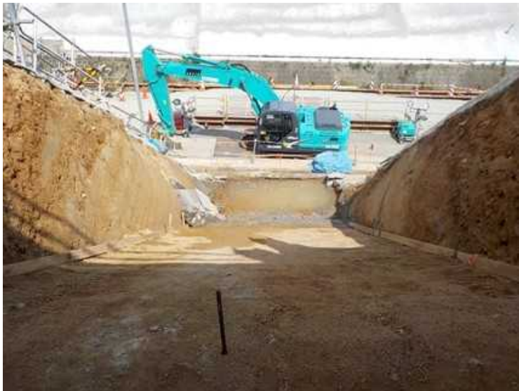
写真② 地下水BP→大熊通り接続部 斜路掘削
