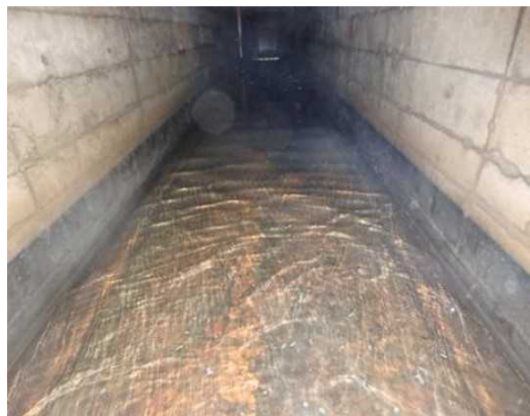
<排水路清掃状況>
