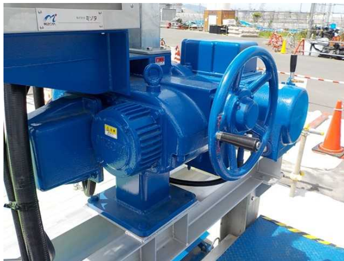
写真 ゲート巻上機電動化状況
