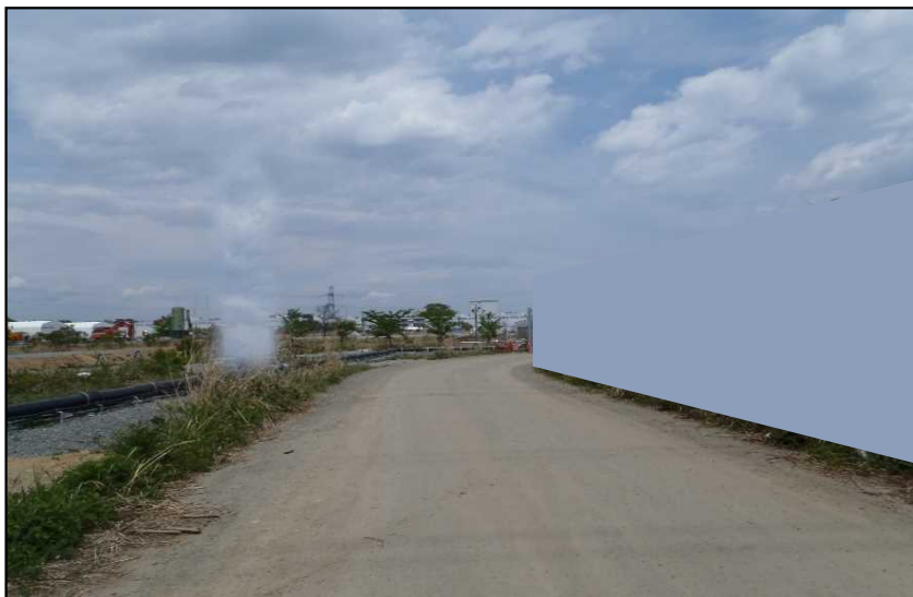
【写真③(35m盤)】地下BPエリア:アスファルト施工前
