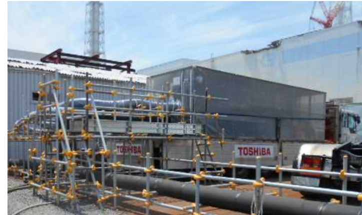
モバイル式処理装置
