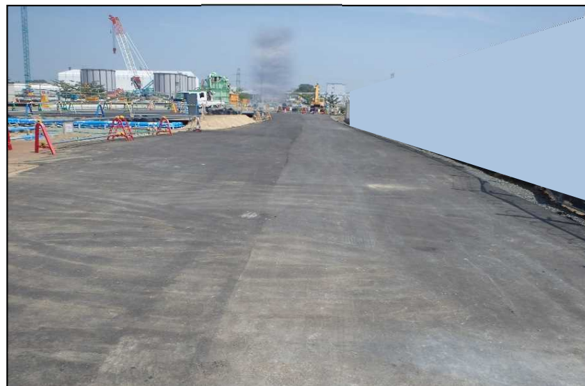
【写真③(35m盤)】地下BPエリア:アスファルト施工後
