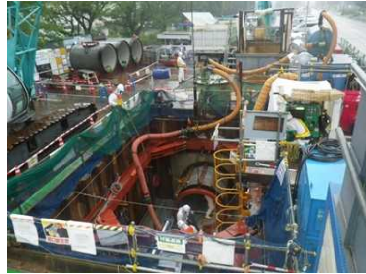
写真③ 桜通り駐車場・南側接続柵部 推進管路到達
