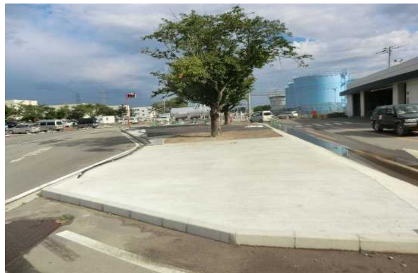
【写真⑥(35m盤)】Hタンクエリア:吹付け施工後
