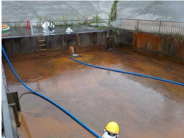
上流部清掃状況
