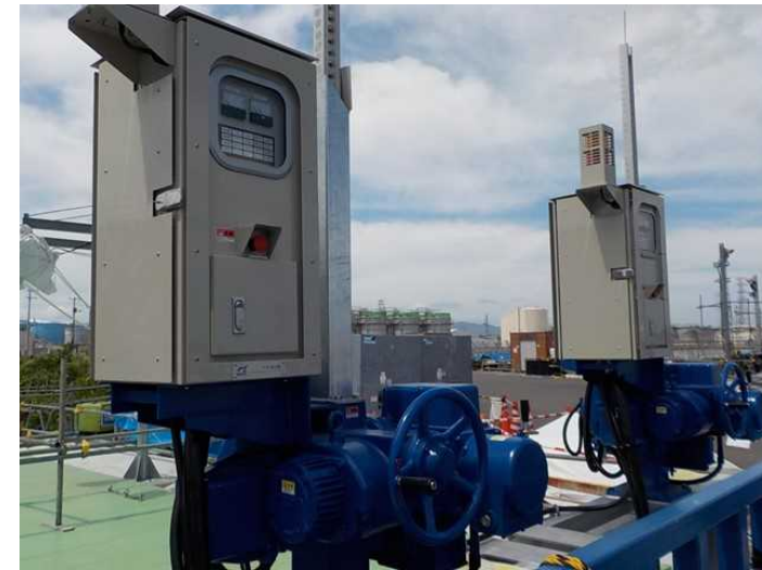
写真 自動・遠隔制御盤設置状況
