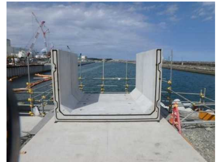
写真③ 放流口部 放流口開渠設置
