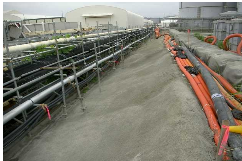
【写真⑥(35m盤)】Hタンクエリア:吹付け施工後
