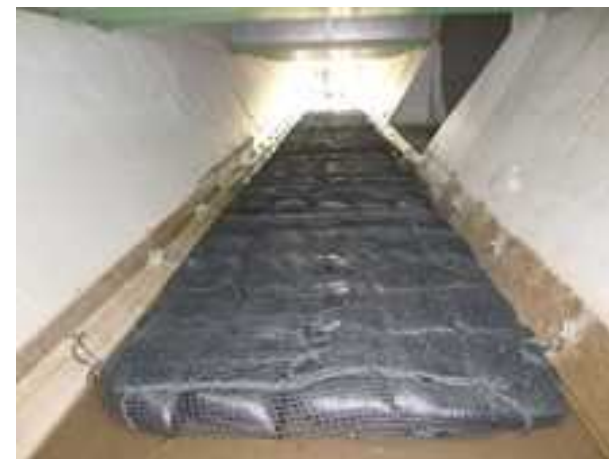
<浄化材の設置>
