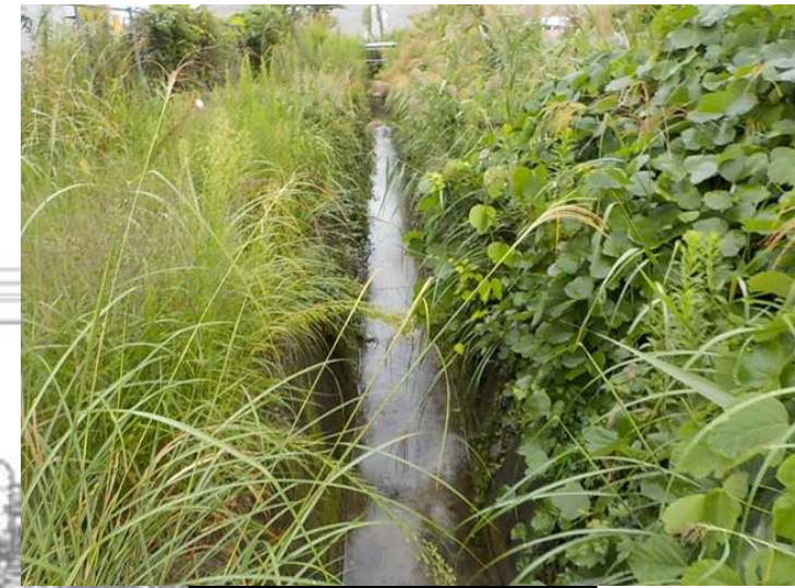
上流部清掃予定箇所
