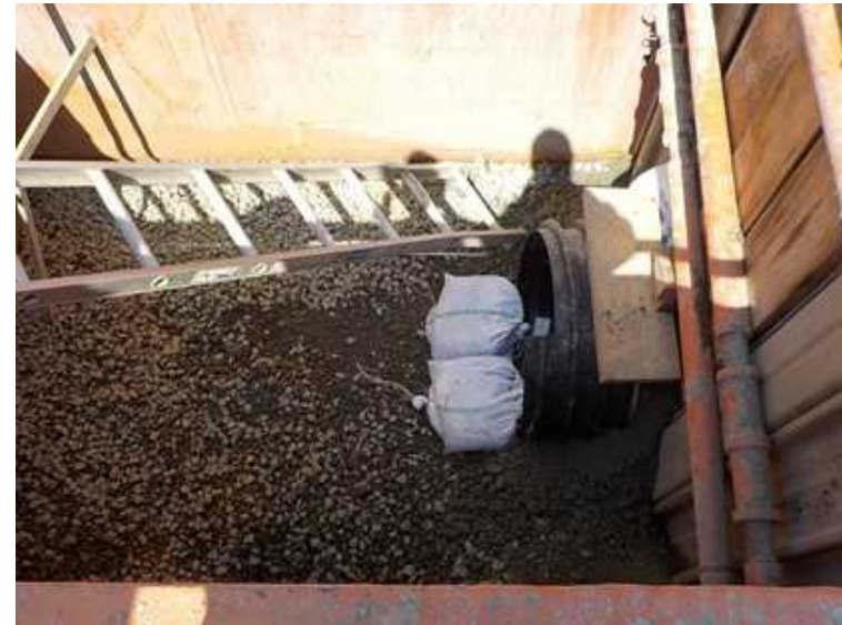
写真④ 大熊通り 排水管路構築
