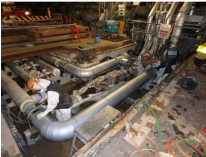
供給管接続作業 8/26
