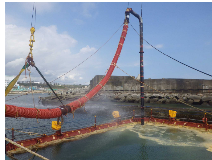
根固石の被覆イメージ
