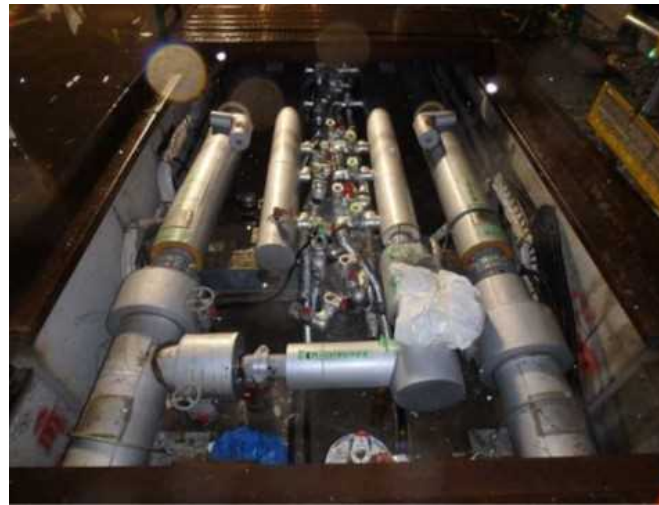
供給管接続後 8/27
