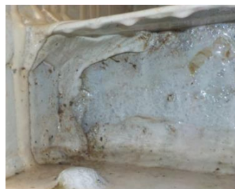
漏洩箇所内側の状況
