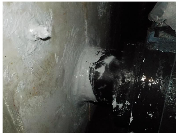
応急措置実施状況
