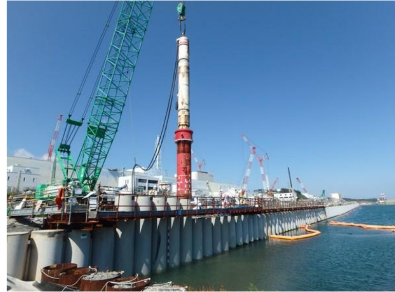
④ 鋼管矢板打設完了後
