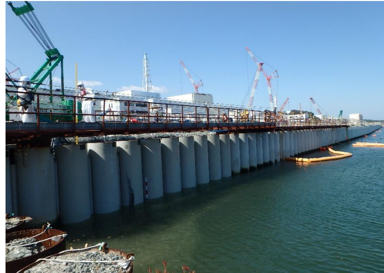
④ 鋼管矢板打設完了後
