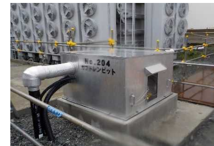
①サブドレンピット (41カ所)
