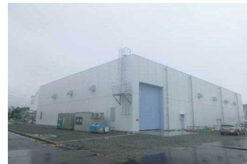
③サブドレン浄化設備建屋
