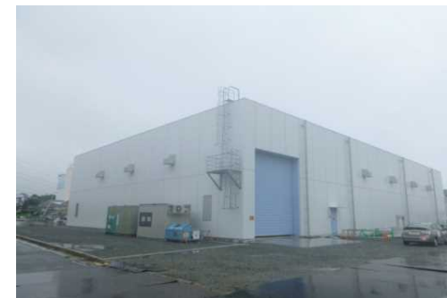
③サブドレン浄化装置建屋
