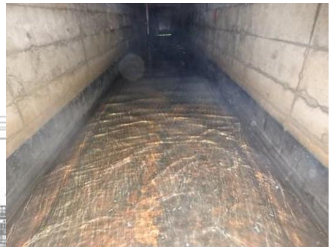
清掃完了状況
