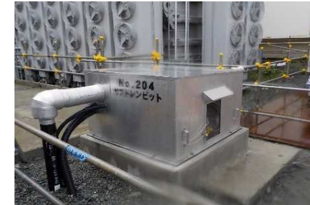
①サブドレンピット (41カ所)
