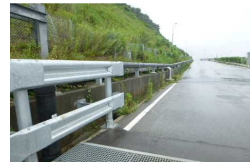
③排水配管
