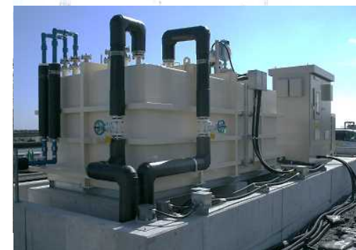
②地下水ドレン中継タンク (3基)
