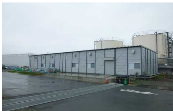
①移送設備建屋
