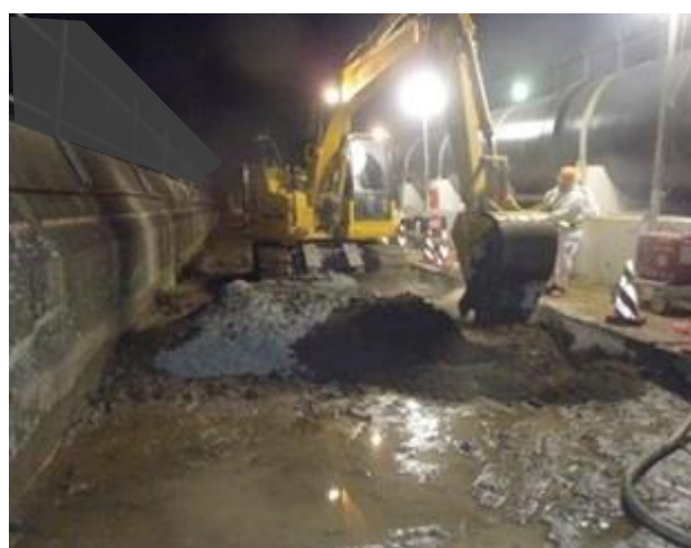
写真② 南護岸部 地盤改良工
