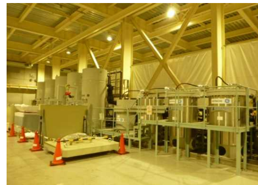
④サブドレン他浄化設備
