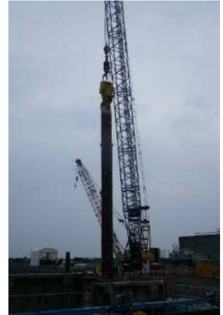
鋼管矢板一次打設状況
