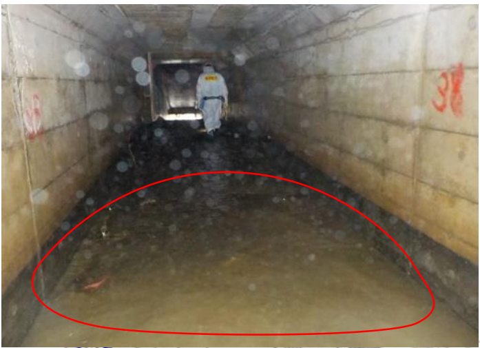
清掃前堆砂状況
