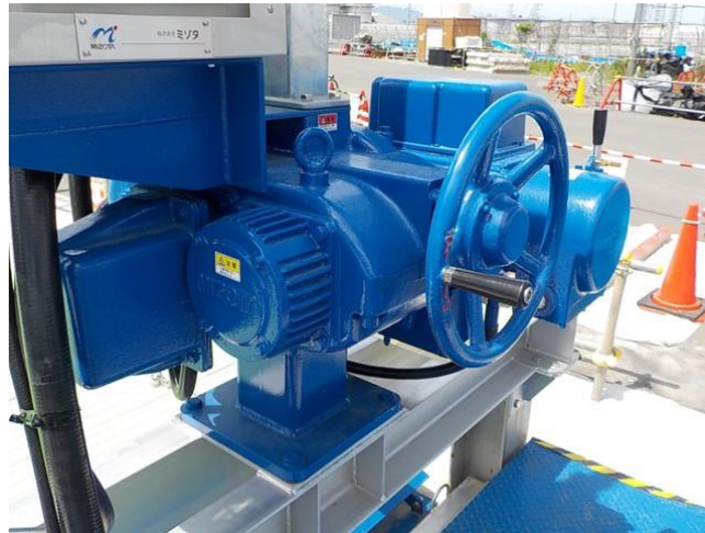
写真 ゲート巻上機電動化状況
