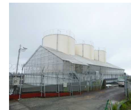
③集水タンク (3基)
