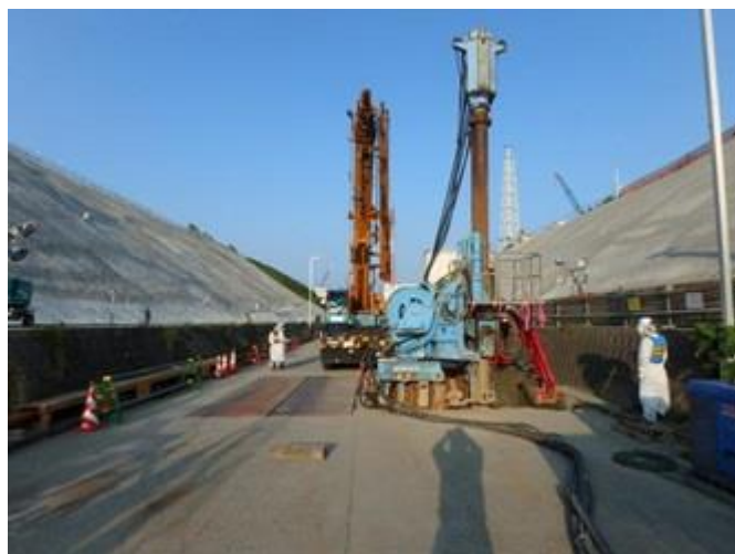
写真② 地下水BP→大熊通り接続柵部 立坑構築
