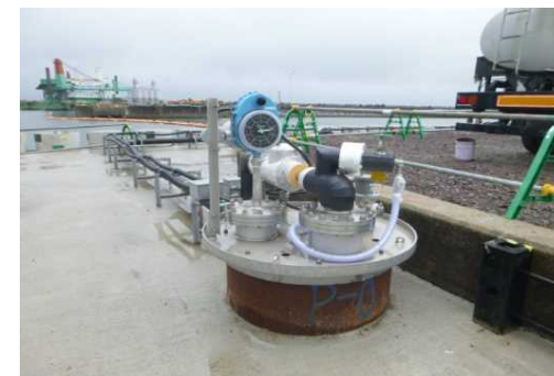
①地下水ドレンポンド (5カ所)
