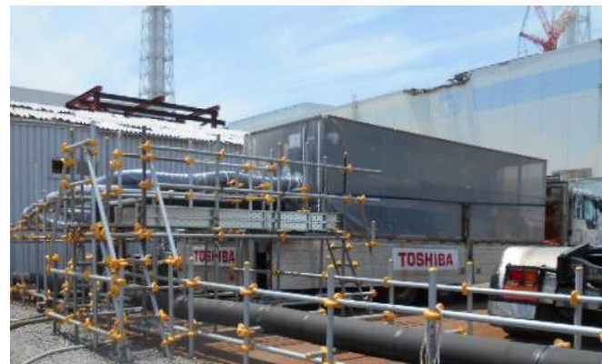
モバイル式処理装置
