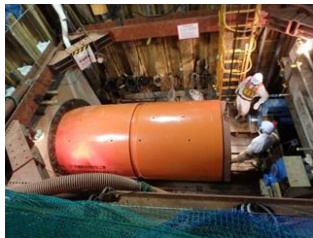
写真③ 桜通り駐車場・南側接続柵部 推進機投入・接続
