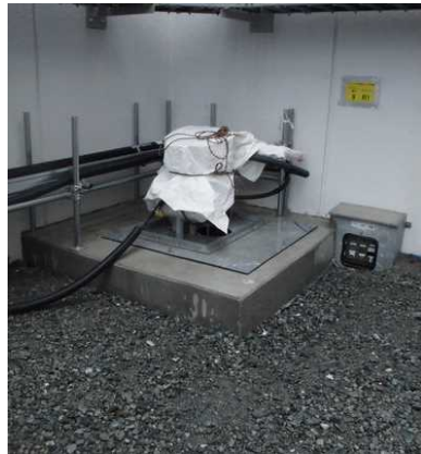
サブドレンピット
