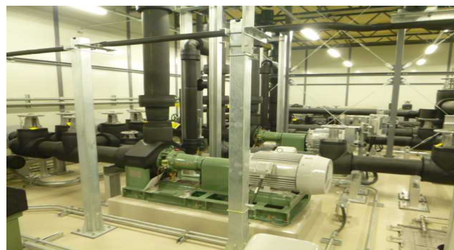
②浄化水移送ポンプ・攪拌ポンプ (2台)
