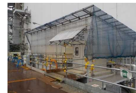
②サブドレン中継タンク (5基)
