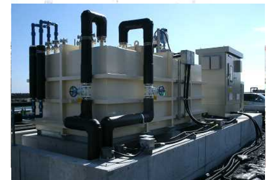
②地下水ドレン中継タンク（3基）
