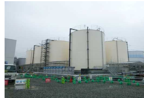
⑥一時貯水タンク (7基)
