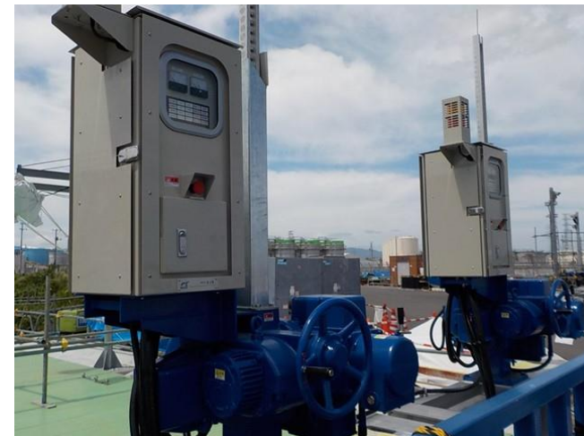
写真 自動・遠隔制御盤設置状況
