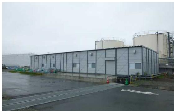
①移送設備建屋
