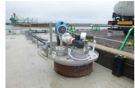
①地下水ドレンポンド（5カ所）
