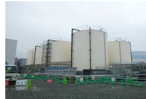
⑥一時貯水タンク（7基）
