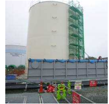
一時貯水タンク
