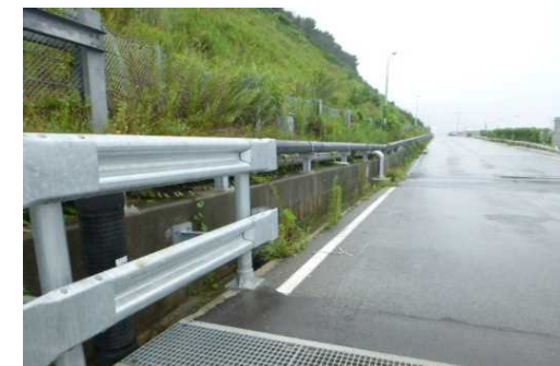
③排水配管
