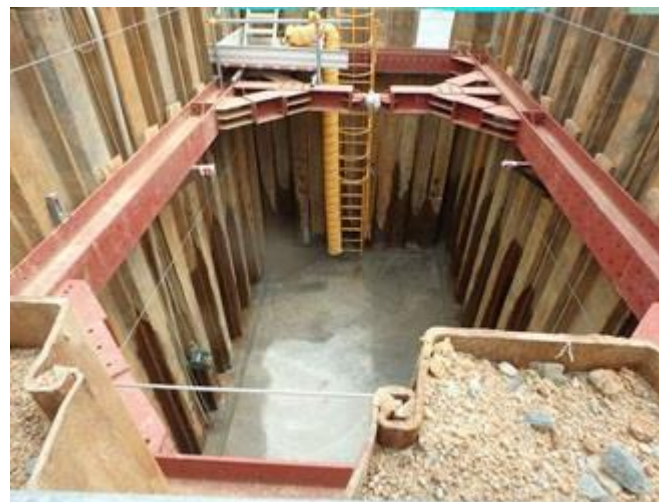
写真④ 大熊通り接続柵部 発進立坑構築
