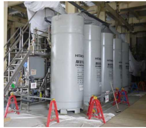
浄化設備 (吸着塔)
