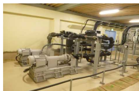
②集水タンク移送ポンプ (2台)
