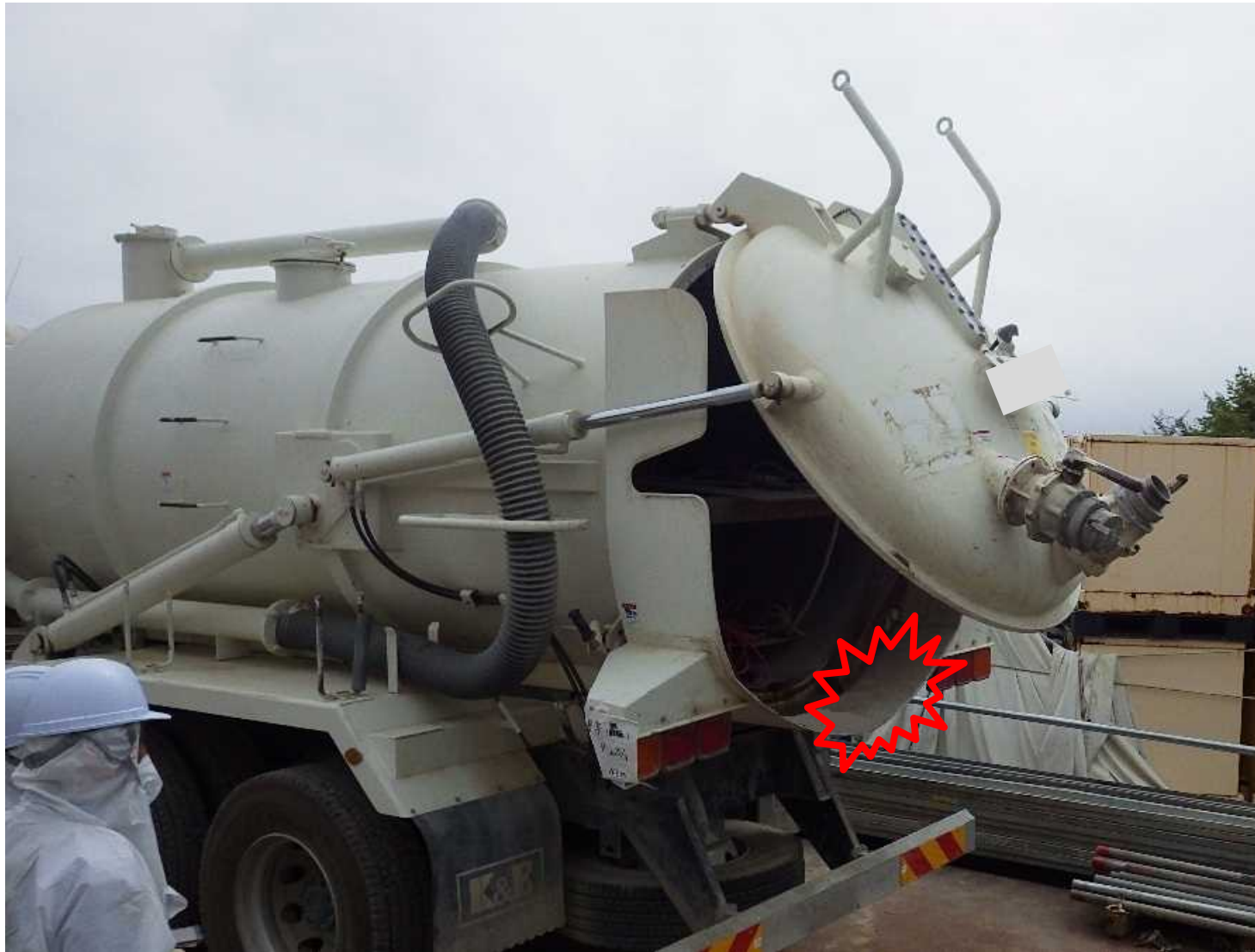
後部タンク蓋開閉動作の確認状況
