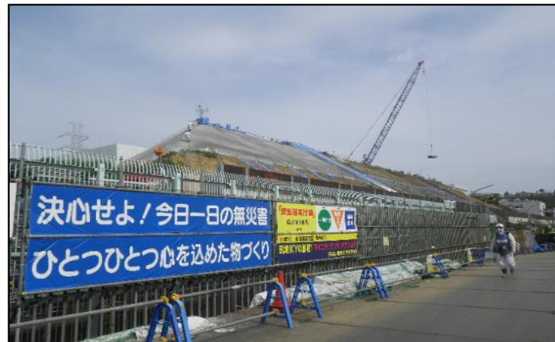
【写真④(35m盤)】1～4号法面:モルタル吹付け施工後
