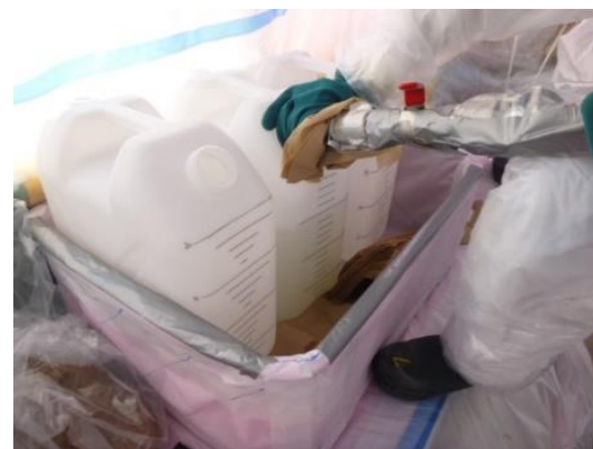
回収用タンク
