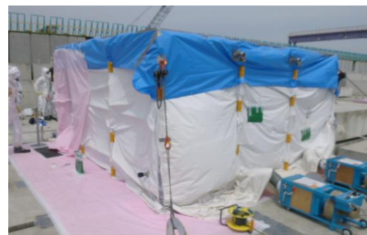
作業ハウス全景
