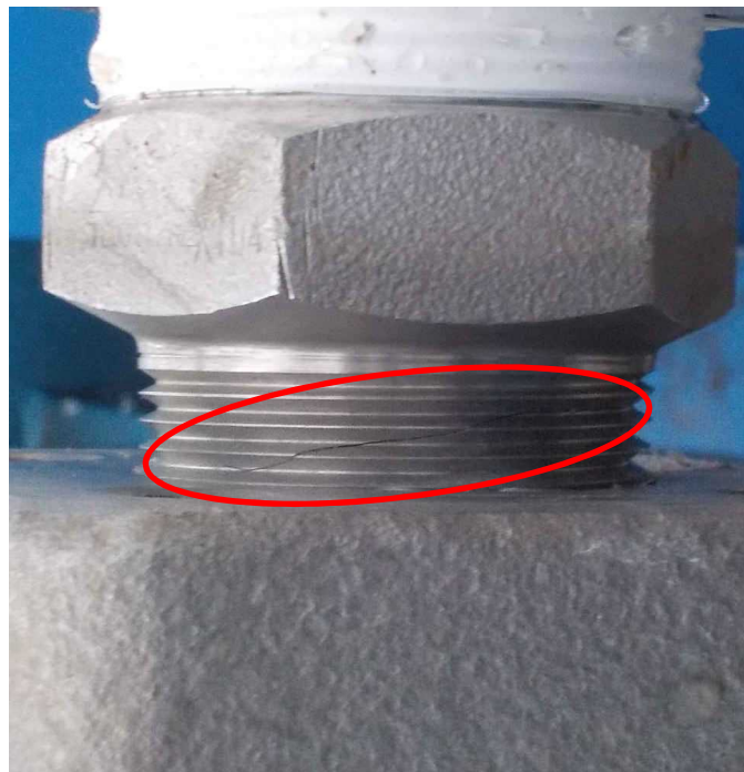
継手(ニップル)ネジ部の割れ
