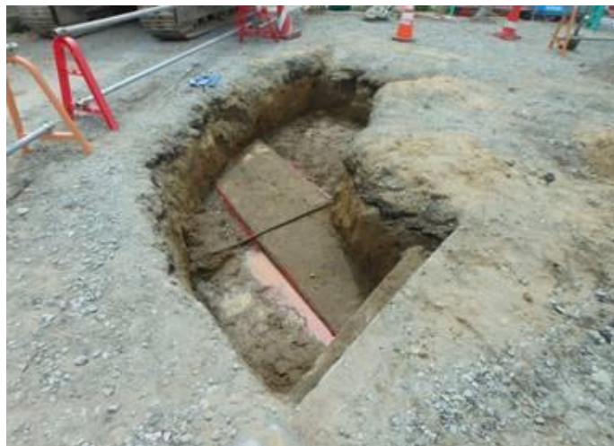
写真① 接続柵部 埋設物調査
