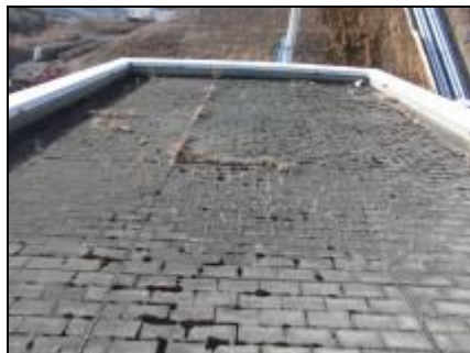
【写真①】作業前
