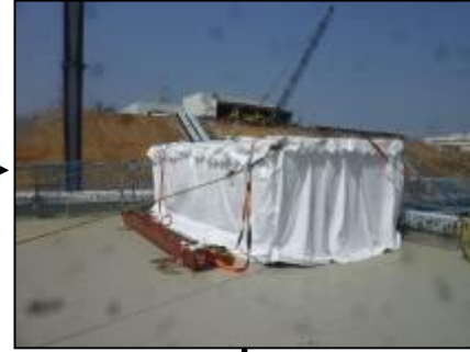
【写真④】仮設テント設置完了 (3月31日)
