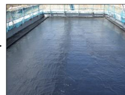
【写真⑪】仕上げ防水 (4月25日)
