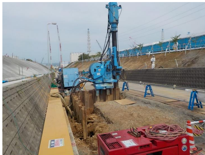
写真③ 西側工リア接続柵部 土止矢板打設
