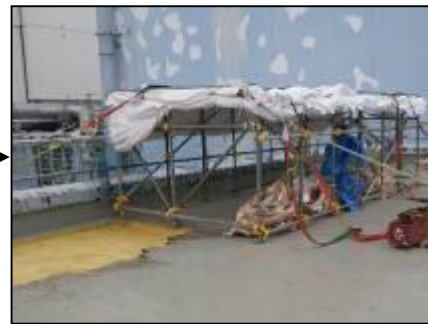
【写真⑧】仮設テント盛替状況 (4月1日)
