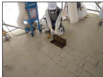
【写真⑤】汚染源撤去開始 (3月30日)
