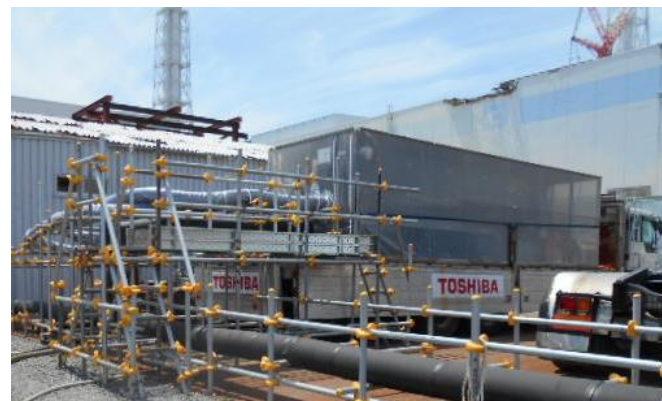
モバイル式処理装置
