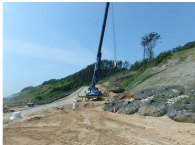
写真② 接続柵部 造成
