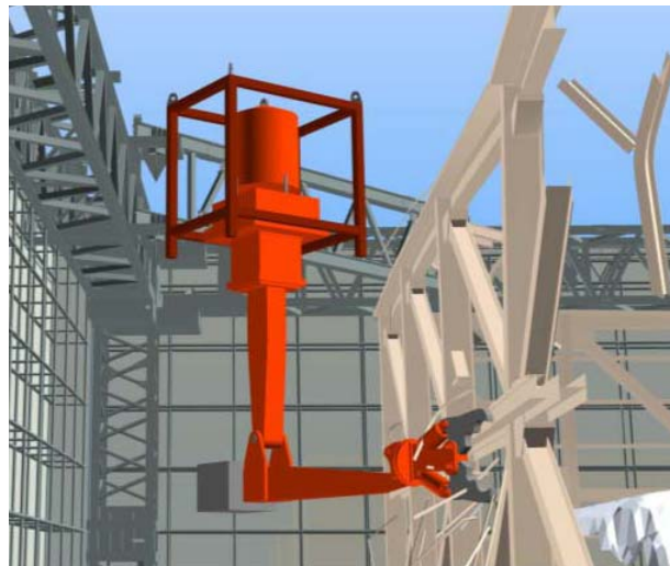
支障となる鉄骨の切断イメージ
