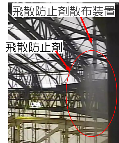
飛散防止剤散布状況
