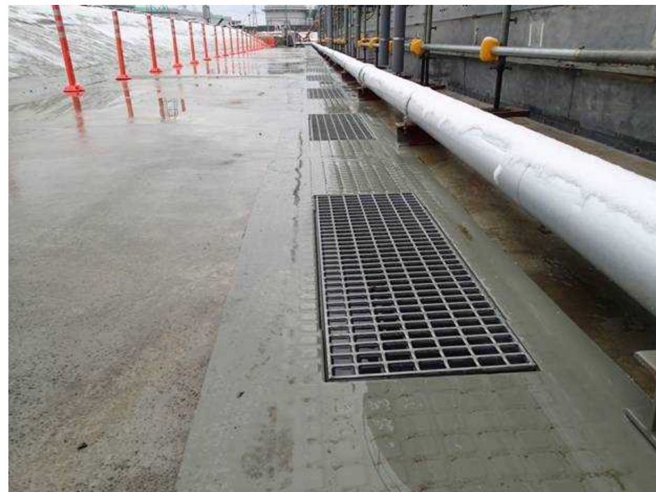
側溝の補修状況（H 6 エリア）
