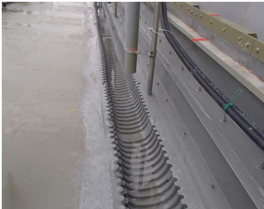
側溝の補修状況（H 4 エリア）
