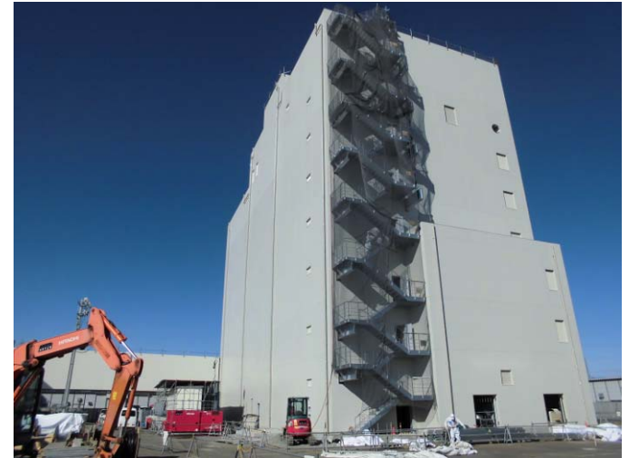
【現状】 内装工事実施中
