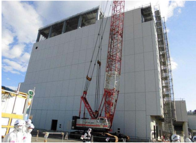
【前回公表時】 外壁工事実施中
