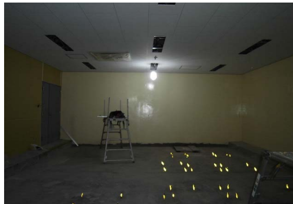
3階制御室 内装工事作業中
