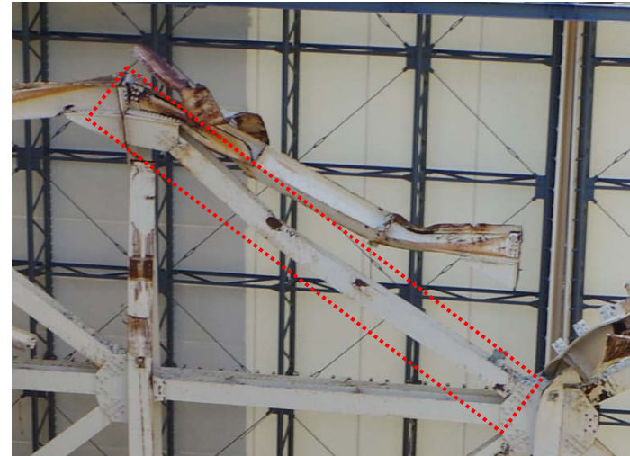
④ 9a-8a通り間上部 鉄骨損傷
