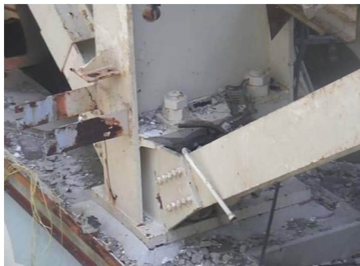
② 9a通り柱脚 健全
