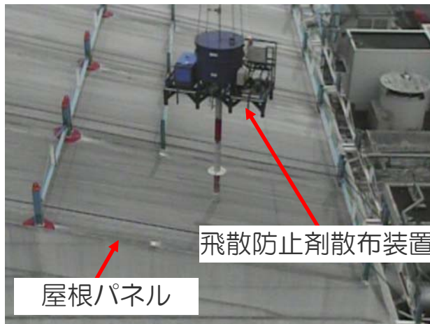
屋根パネルへの孔あけ状況
