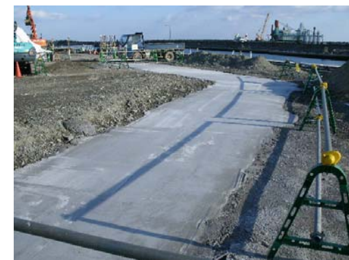
① 地表部処理完了箇所 (H27/1/20)
