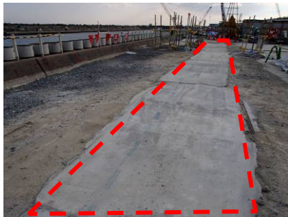
①モルタル置換完了
