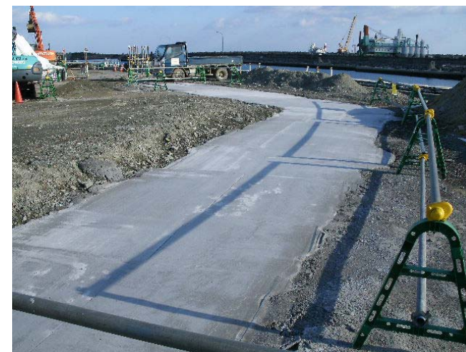
① 地表部処理完了箇所 (H27/1/20)
