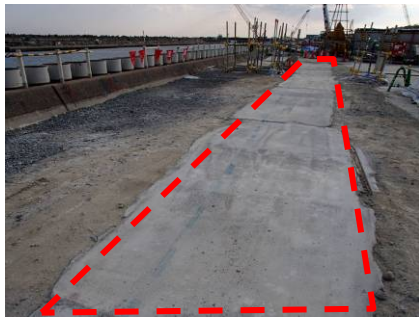
①モルタル置換完了
