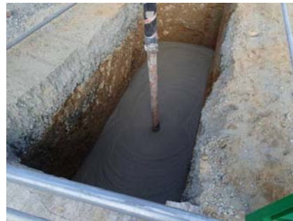
②モルタル置換施工
