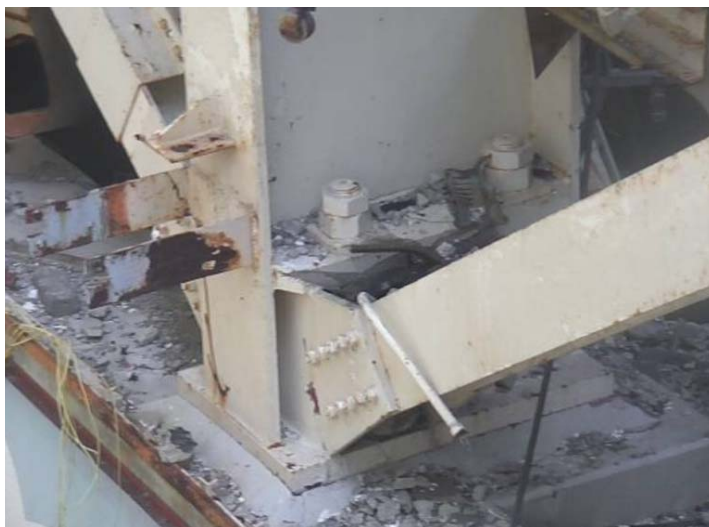
② 9a通り柱脚 健全
