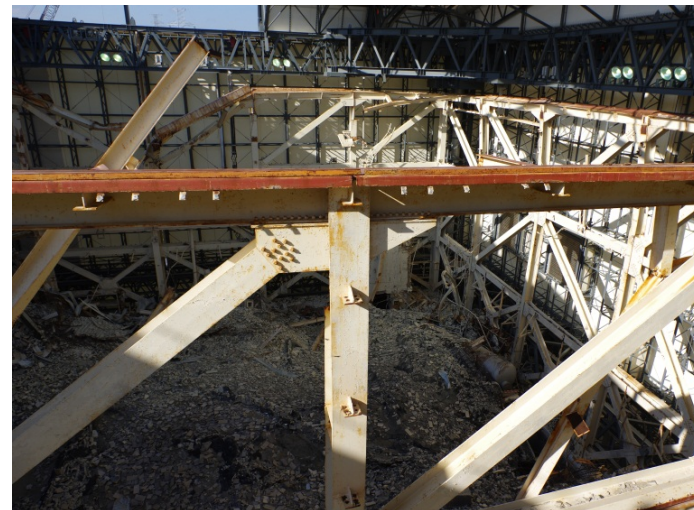
① 7a柱上部梁 健全
