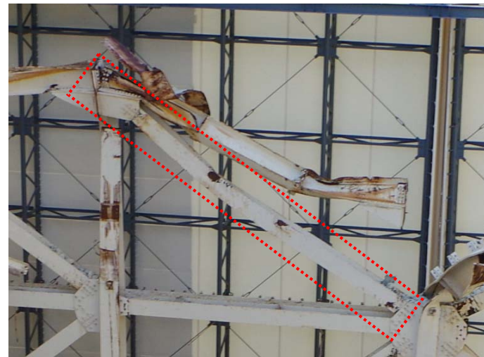
④ 9a-8a通り間上部 鉄骨損傷
