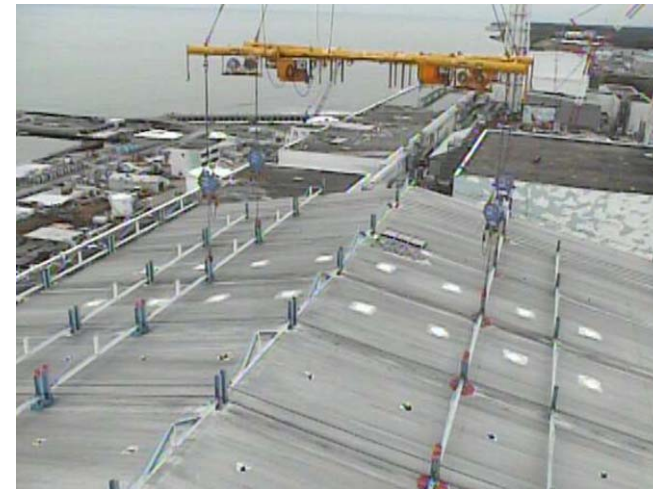
屋根パネル戻し状況（12/4）
