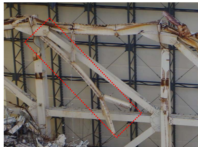
⑥ 西面10a通り付近上部 鉄骨損傷
