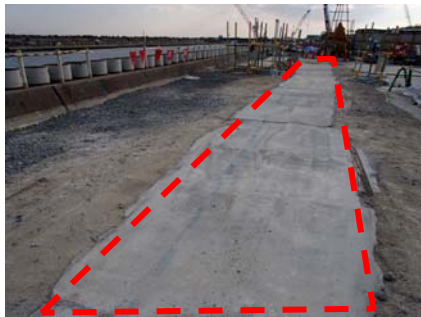
①モルタル置換完了
