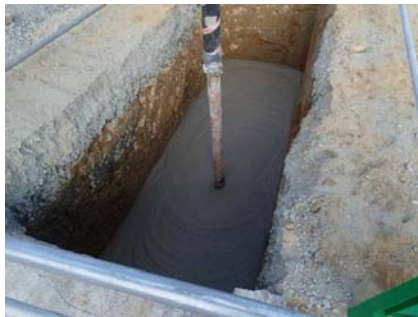
②モルタル置換施工
